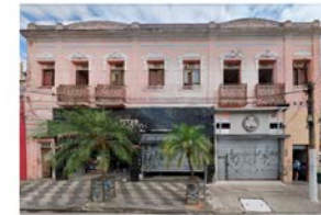
SITUAÇÃO ATUAL DO BEM DE 2015 DA FACHADA DA EDIFÍCIO ORIGINAL DA RUA DAS MOTOS
