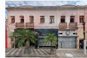
SITUAÇÃO ATUAL EMPOCO DE 2023 DA FACHADA DA COOPEDUCADORA
