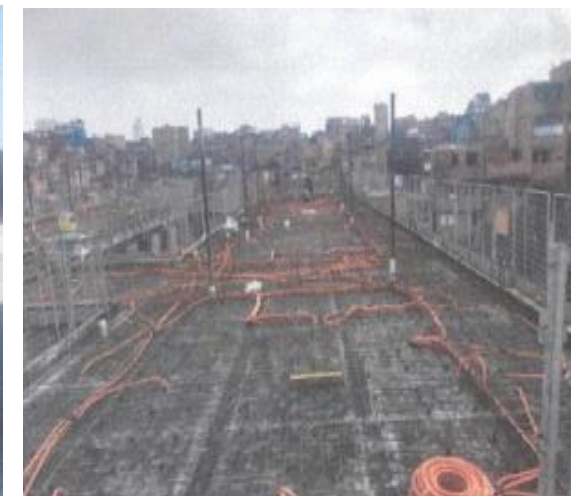
Laje – Forma, Armação e Conduítes -Foto: set./23.
