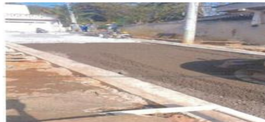
Execução de Pavimento - Foto: set./23
