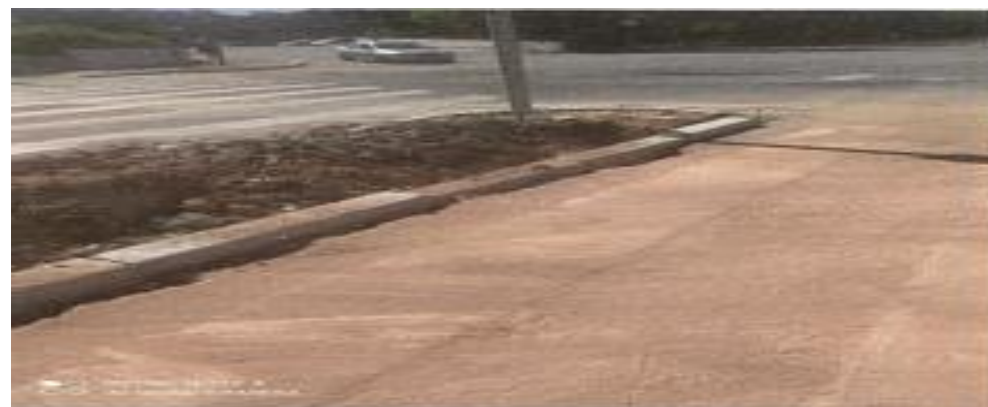
Colocação de Guias retas e aplicação de terra – Foto: jun./23.
