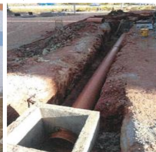
Condomínio 5 – Execução de Redes Condominiais - Foto: set./23
