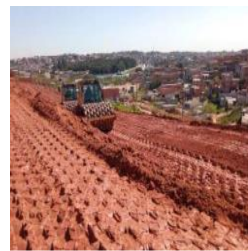
Nova Grajaú- Terraplenagem do Viário - Foto: set./23.
