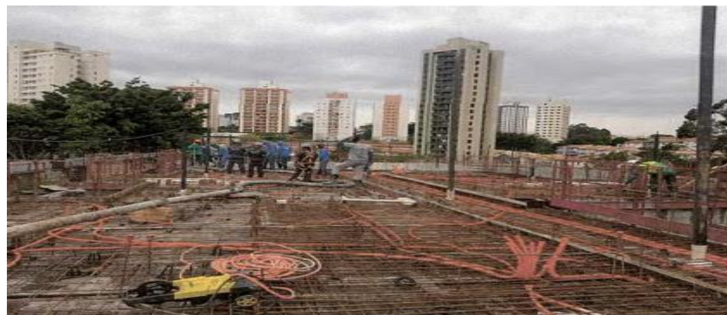
Armação, eletroduto e forma – Foto: ago./23.
