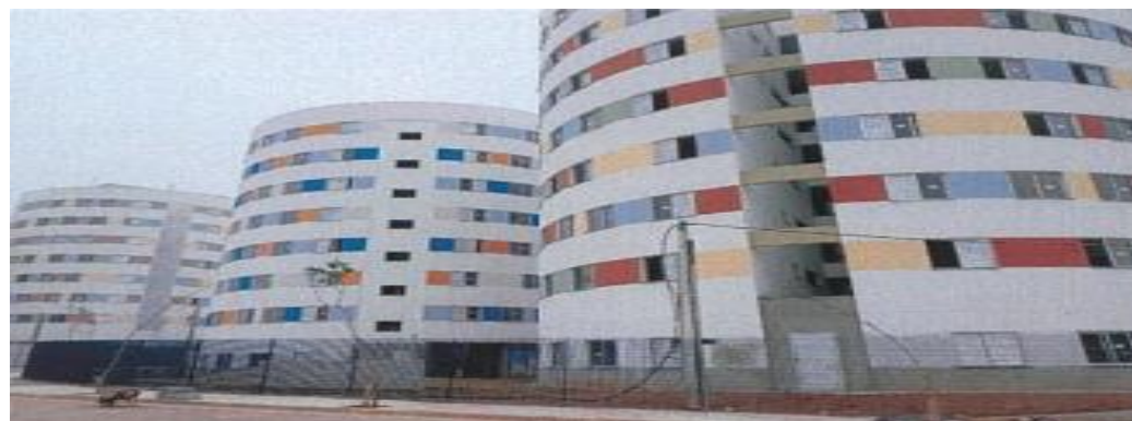
Condomínio 5 - Instalação de Gradil - Foto: set./23
