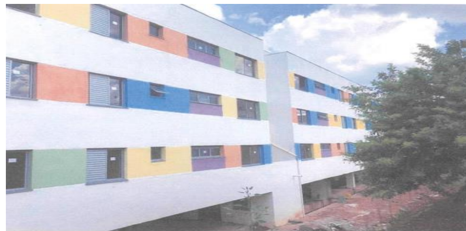
Pintura Externa – Fotos: mai./23.
