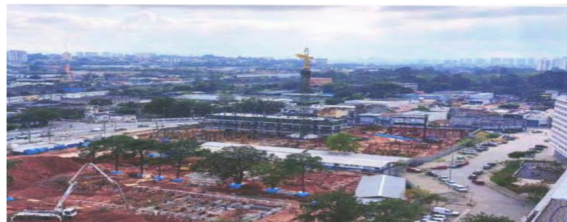
Visão Geral da Obra – Foto: set./23.
