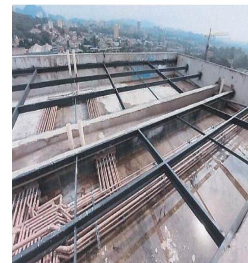
Torre A – Estrutura metálica da cobertura – Foto: set./23.
