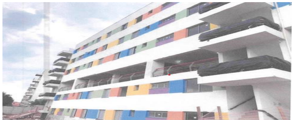
Pintura Externa – Fotos: mai./23.
