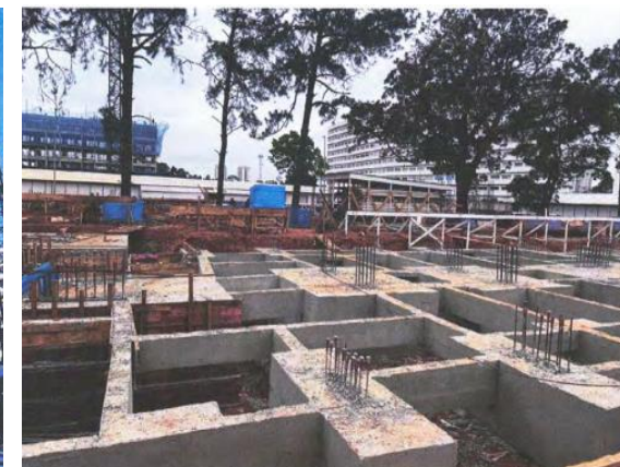
Vigas Baldramas e Blocos da Torre 4 Foto: set./23.
