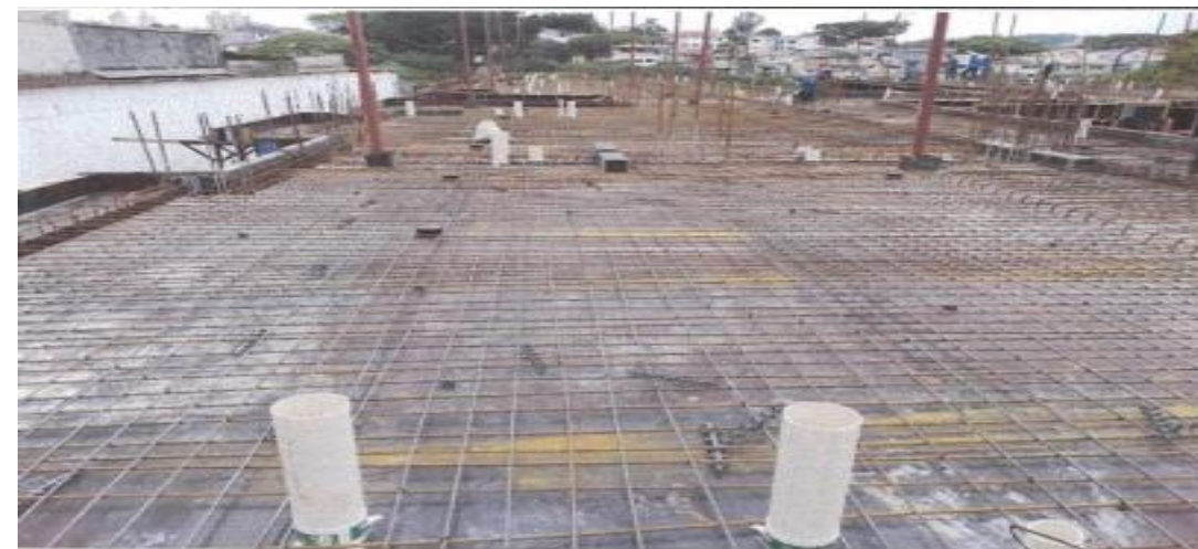
Cond. A – Armadura em Aço CA-50 /CA-60 - Foto: set./23.
