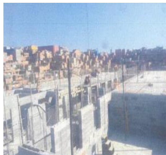
Alvenaria Estrutural- Foto: set./23
