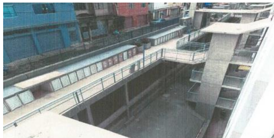
Bloco E –Projeto Talude- Foto: ago./23.
