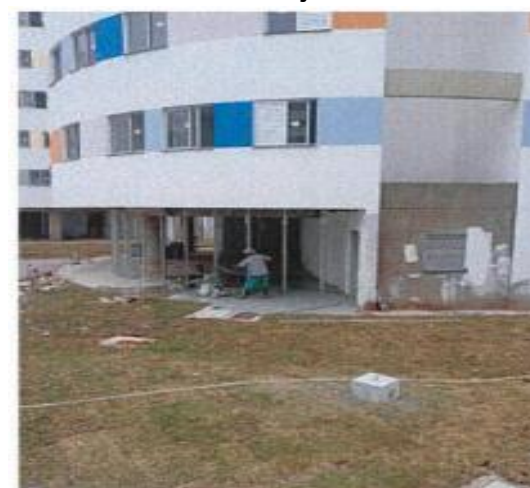
Condomínio 5 - Execução do Piso de Alta Resistência- Foto: set./23
