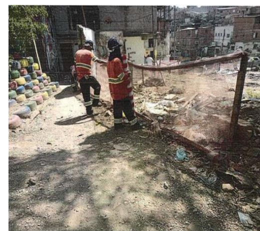
Realização da para Sinalização do Trecho 1 - Foto: set./23
