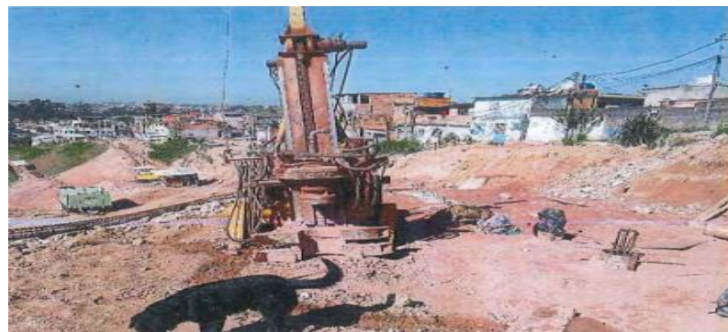
Execução de Estaca Raiz Muro 6 a 9 e 10 a 14 – Rua Citadella - Foto: set./23.
