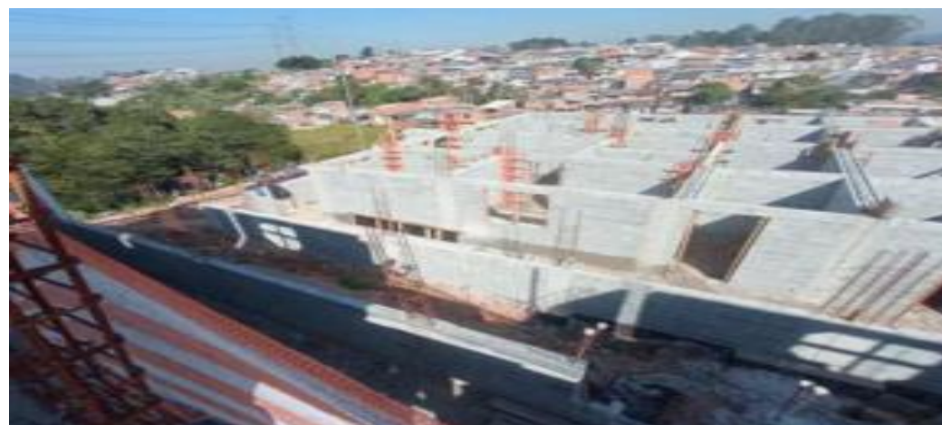
Erundina - Canalização do córrego – Foto: set./23
