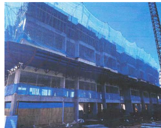
Bandeja e Tela de Proteção da Torre 2 - Foto: set./23
