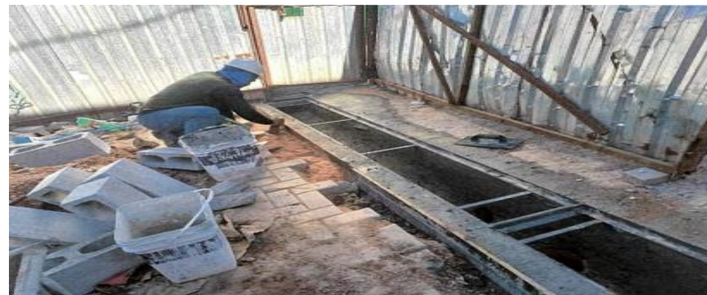
Drenagem da Rua Projetada - Foto: ago./23
