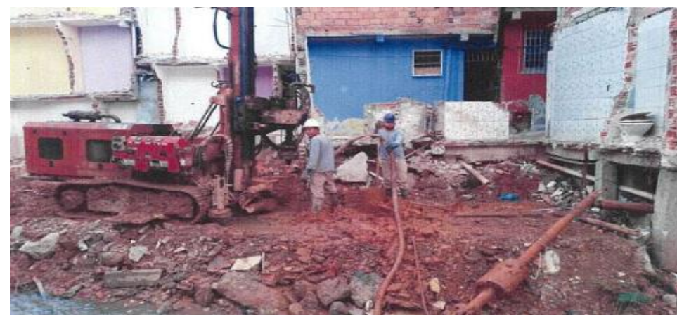
Fase 2-Execução de Estaca Tipo Raiz, 400MM, com Perfuração- Foto: ago./23.
