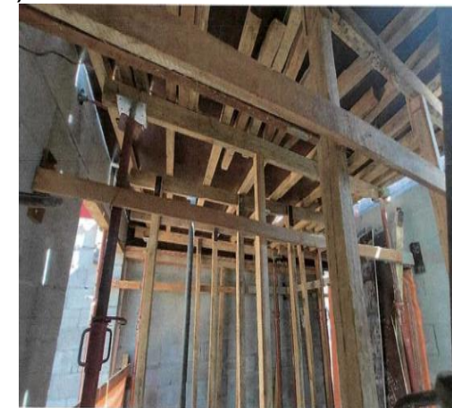
Escoramento e forma de Laje -Foto: ago./23
