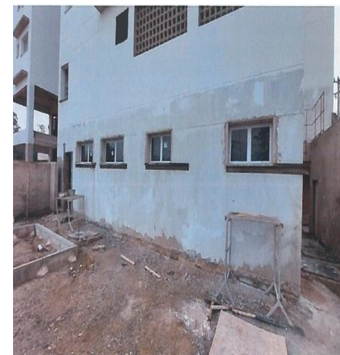
Caixilhos das Creche -Foto: set./23.
