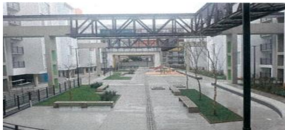
Execução de Steel Deck – Fotos: mar./23.
