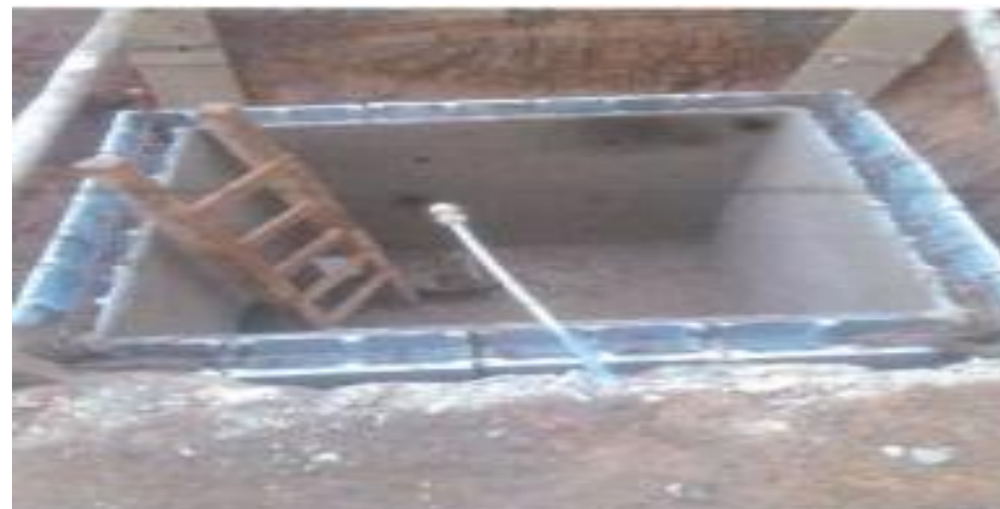
Execução de Rede de Drenagem - Foto: set./23.
