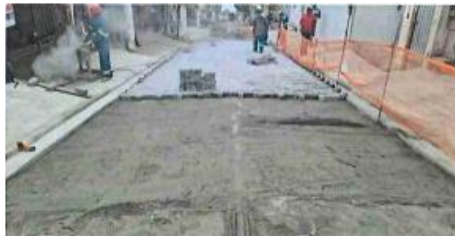
Monte Verde – Rua da Paz: Assentamento de Guias, sarjetão, intertravado Foto: ago./23
