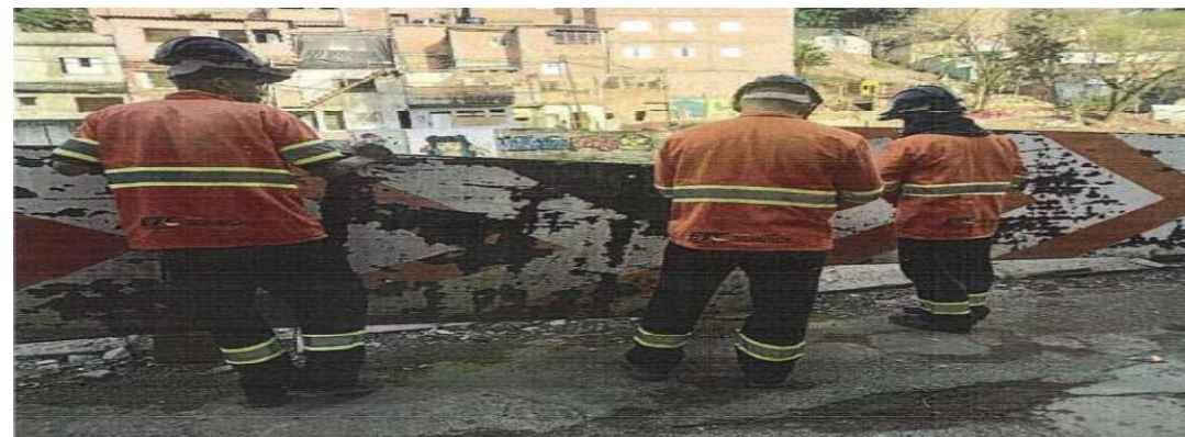
Realização da Manutenção Tapumes de Madeira, para Sinalização do Trecho 1 - Foto: set./23
