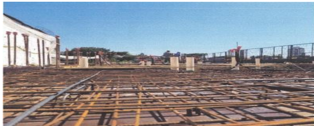
Cond. A – Armadura em Aço CA-50 - Foto: set./23.
