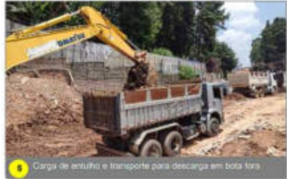
5 Carga de entulho e transporte para descarga em bota fora
