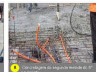
8 Concretagem da segunda metade do 6º pavimento
