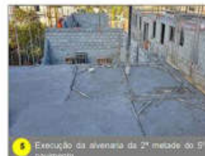
5 Execução da alvenaria da 2ª metade do 5º pavimento.
