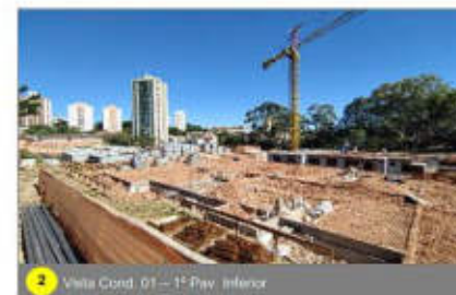
2 Vista Cond. 01 – 1º Pav. Interior
