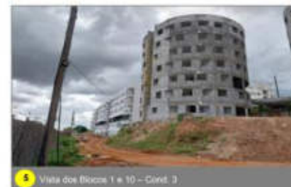
5 Vista dos Blocos 1 e 10 – Cond. 3
