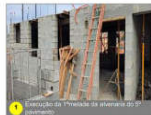
1 Execução da 1ª metade da alvenaria do 5º pavimento.
