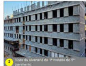
2 Vista da alvenaria da 1ª metade do 5º pavimento.
