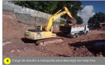
6 Carga de entulho e transporte para descarga em bota fora
