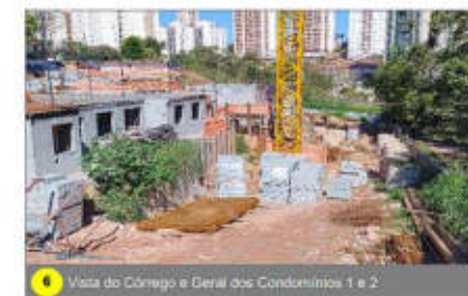
6 Vista do Córrego e Geral dos Condomínios 1 e 2
