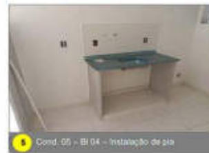
5 Cond. 05 - Bl 04 - Instalação de pia
