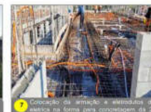
7 Colocação da armadura e eletrodutos de elétrica na forma para concretagem da 2ª metade do 6º pavimento
