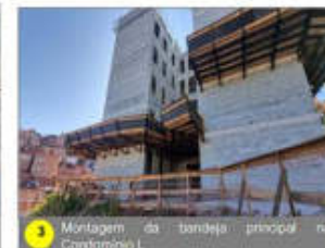
3 Montagem da bandeja principal no Condomínio L.
