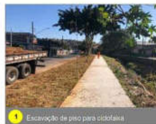
1 Escavação de piso para ciclofaixa
