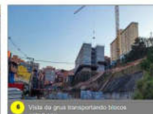
6 Vista da grua transportando blocos estruturais
