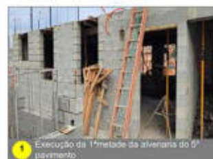
1 Execução da 1ª metade da alvenaria do 6º pavimento
