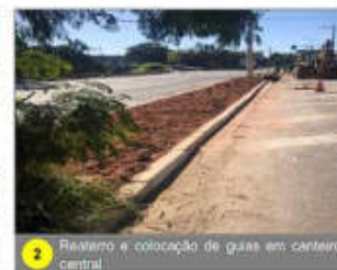
2 Relevo e colocação de guias em canteiro central
