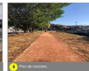
8 Piso de concreto
