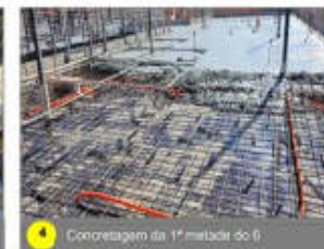
4 Concretagem da 1ª metade do 6º pavimento.
