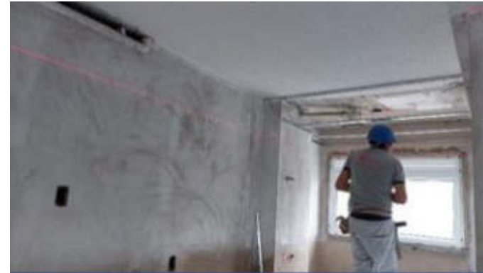
Torre A - Execução de forro de gesso no teto das áreas molhadas dos apartamentos
