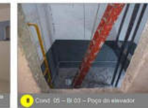
8 Cond. 05 - Bl 03 - Poço do elevador
