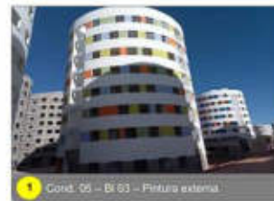
1 Cond. 05 - Bl 03 - Pintura externa
