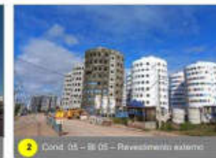
2 Cond. 05 - Bl 05 - Revestimento externo
