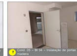
7 Cond. 05 - Bl 04 - Instalação de portas de madeira
