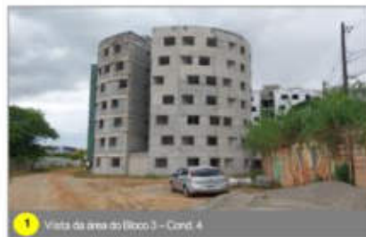
1 Vista da área do Bloco 3 – Cond. 4
