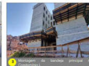
3 Montagem da bandeja principal no Condomínio L
