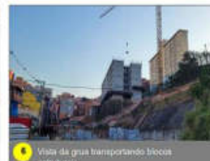
6 Vista da grua transportando blocos estruturais.
