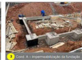
3 Cond. A – impermeabilização da fundação
