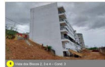
6 Vista dos Blocos 2, 3 e 4 – Cond. 3
