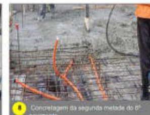
8 Concretagem da segunda metade do 6º pavimento.
