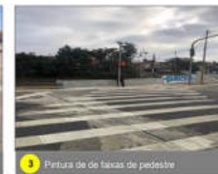
3 Instalação de placas de pedestre
