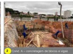
2 Cond. A – concretagem de blocos e vigas
