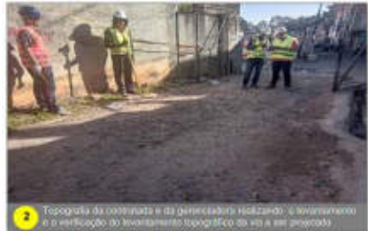
2 Topografia da contravista e da perspectiva horizontal, e levantamento e a verificação do levantamento topográfico da via a ser construída.
