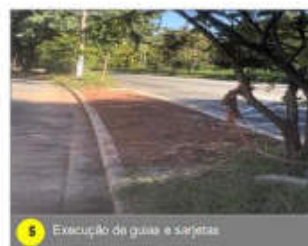
5 Execução de guias e sarjetas
