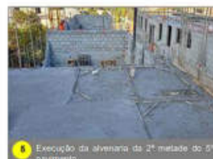
5 Execução da alvenaria da 2ª metade do 6º pavimento
