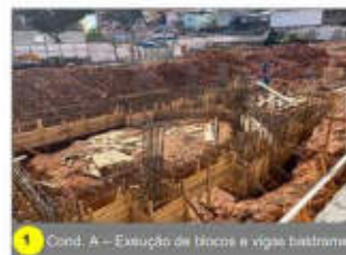
1 Cond. A – Execução de blocos e vigas balstrame
