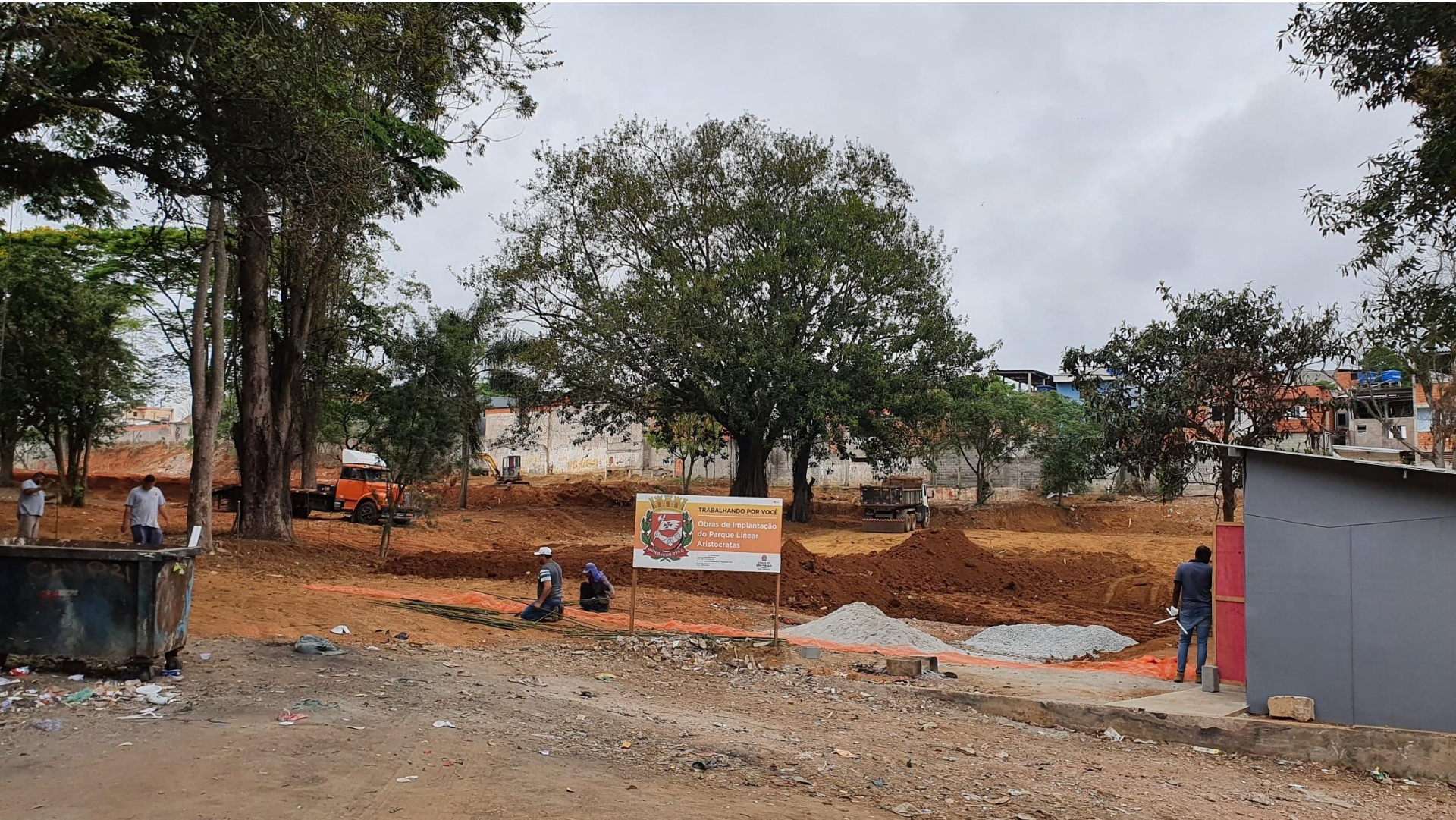
Obras de Implantação em andamento
