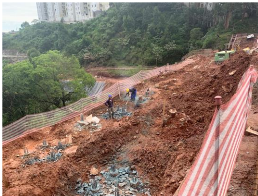
Mata Virgem – execução de arrasamento das estaca raiz
