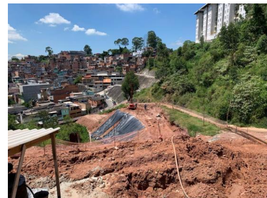
Mata Virgem – execução de estaca raiz da escadaria do patamar
