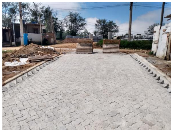
Erundina – execução de pavimento intertravado
