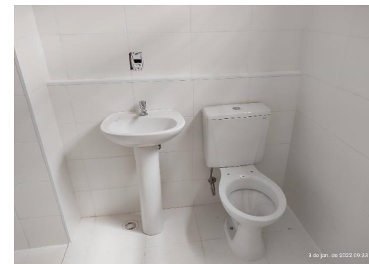
Bloco D – Instalação de metais nos WC das unidades
