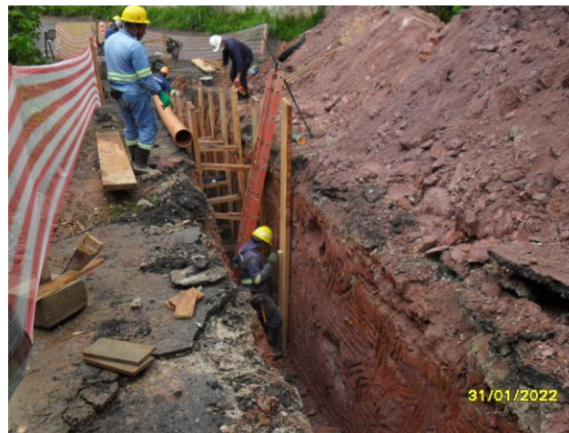
Chácara Flórida – escoramento de valas
