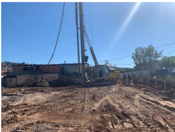
Cidade Julia – execução de estaca hélice e continua da fundação
