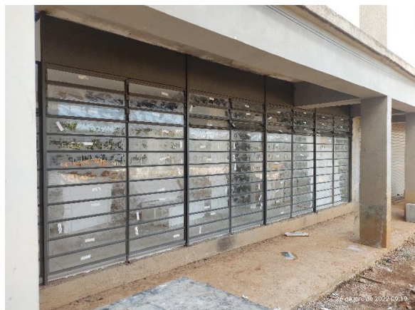
Blocos C – Instalação dos vidros nos caixilhos do térreo
