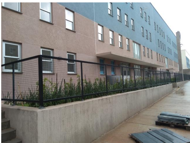
Chácara do Conde - Executando instalação de guarda corpo e corre mãos
