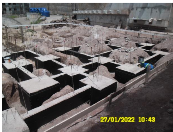
Alto da Alegria - Impermeabilização vigas baldrame e blocos de fundação
