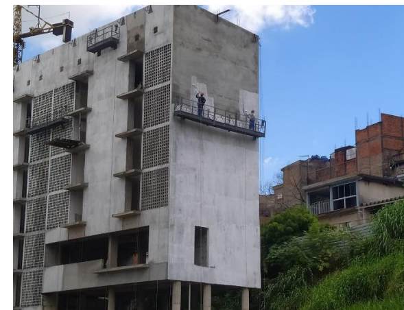
Bloco A – aplicação de fundo preparador na fachada
