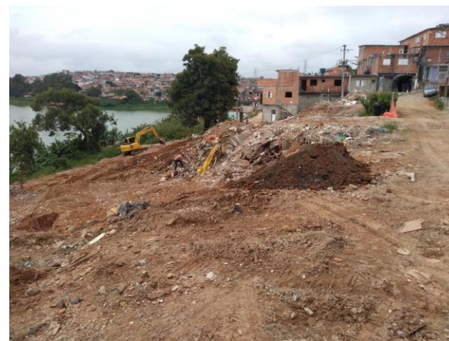
Cantinho do Céu – Executando demolições de casas
