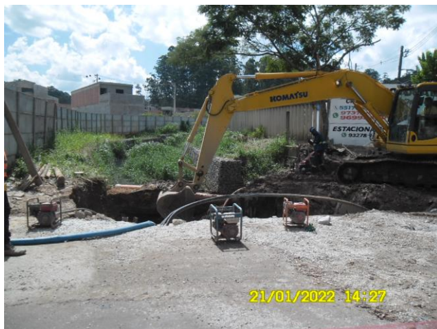
Jardim Tancredo – esgotamento d'água com bomba submersa
