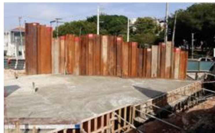
Rede de Extensão do canal no trecho 2 com escoramento em perfis
