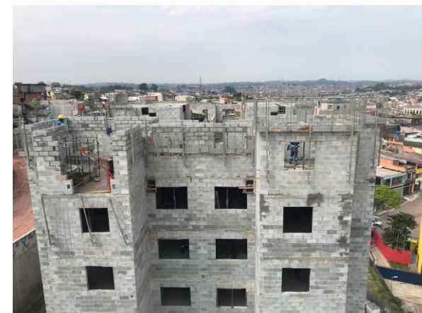
Alto da Alegria - Cond. 6b - Execução da alvenaria do 6º pavimento
