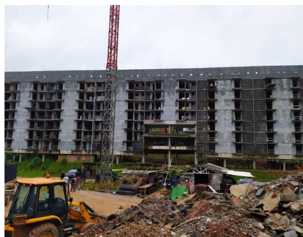
Fachada do bloco E – 78 UHs
