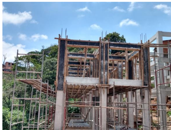
Erundina – execução de estrutura para primeiro deck
