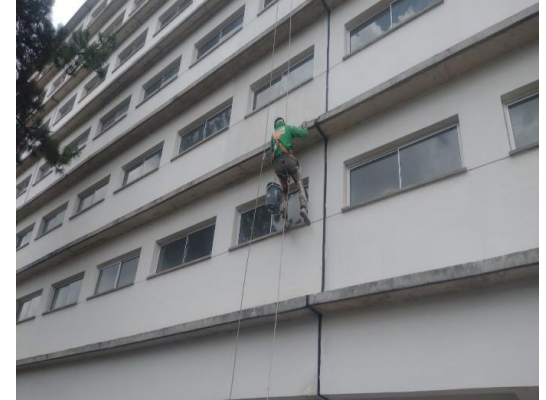
Torre F2 – Pintura da fachada
