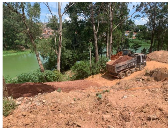
Jardim Apurá – execução de aterro
