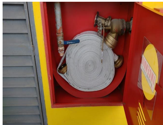
Torre F2 – Instalação dos equipamentos de combate à incêndio
