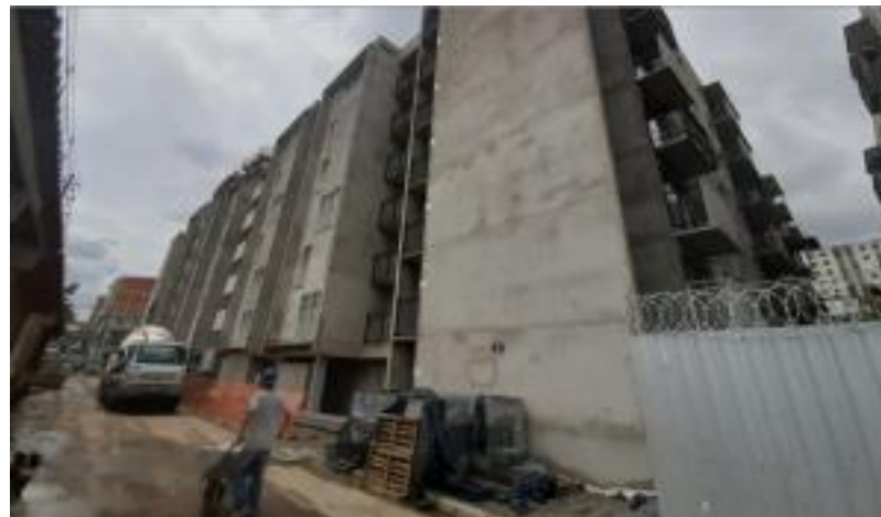
Alvenaria estrutural blocos D e E
