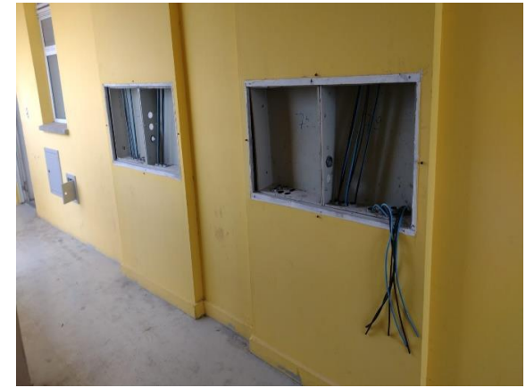
Torre F2 – Revisão das instalações elétricas
