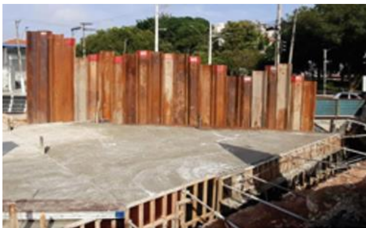
Execução de rede de esgoto
