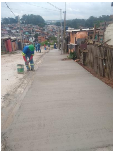
Erundina – execução de passeio
