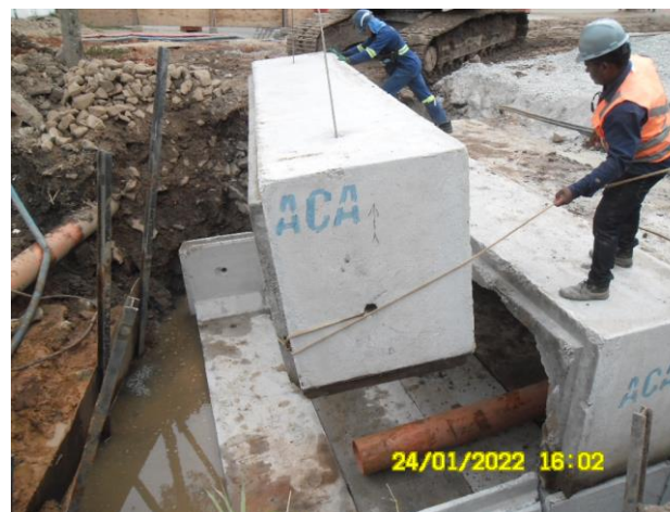
Jardim Tancredo – assentamento de aduelas
