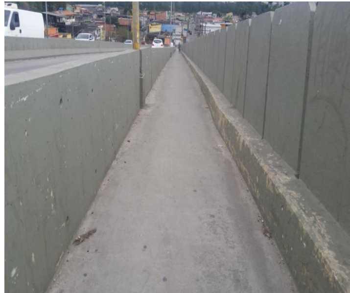
Viaduto Carlito Maia.
