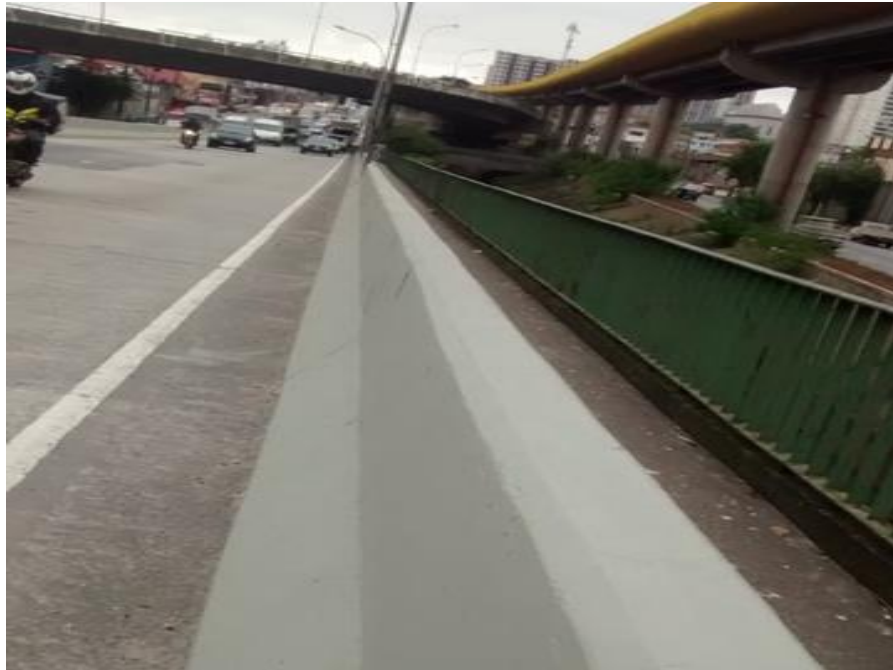
Viaduto Gazeta do Ipiranga Valor empenhado: R$ 20.871,30 Valor liquidado: R$ 20.871,30
