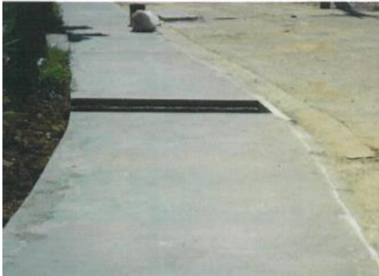
Rua Prof. Hermogenes de Freitas Leitão Filho. Valor empenhado: R$ 129.451,53 Valor liquidado: R$ 129.451,53
