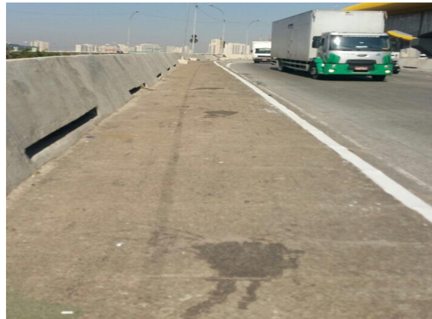
Viaduto Grande São Paulo Valor empenhado: R$ 45.723,17 Valor liquidado: R$ 45.723,17
