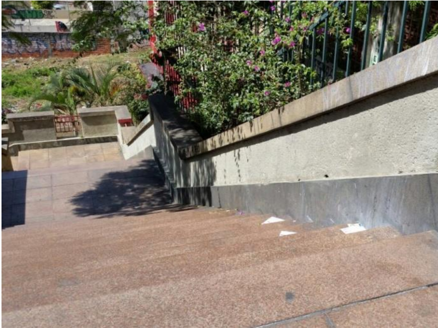
Viaduto Major Quedinho. Valor empenhado: R$ 18.861,22 Valor liquidado: R$ 18.861,22
