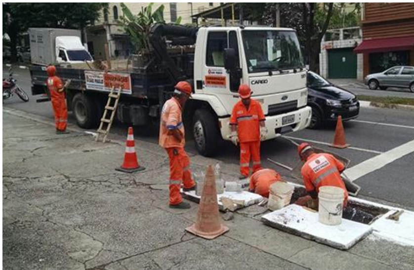
Legenda: Exemplo de Serviço de Drenagem
