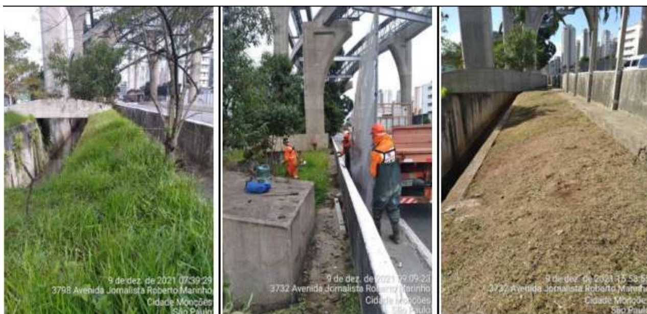
Limpeza de margem de córrego
