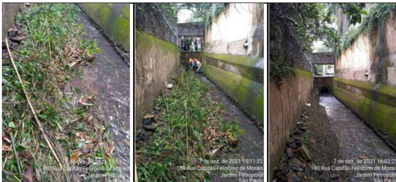
Remoção de detritos em córrego canalizado
