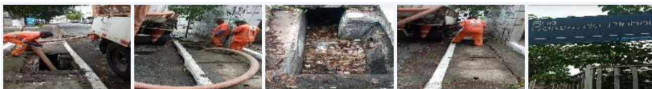
Limpeza de boca de lobo com hidrojato sugador
