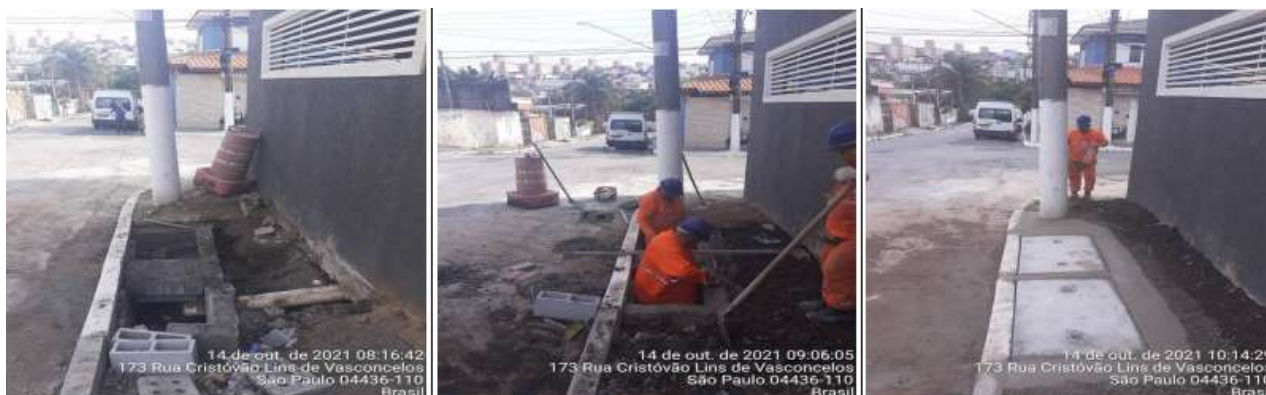
Reforma de boca de lobo
