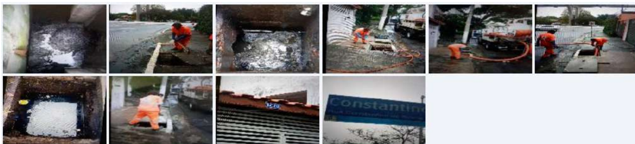
Limpeza de boca de lobo
