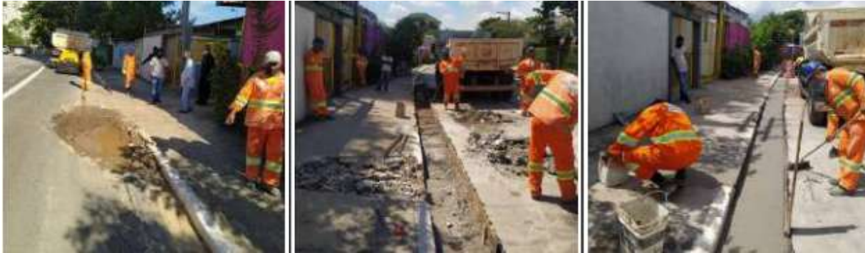
Reforma de sarjetas
