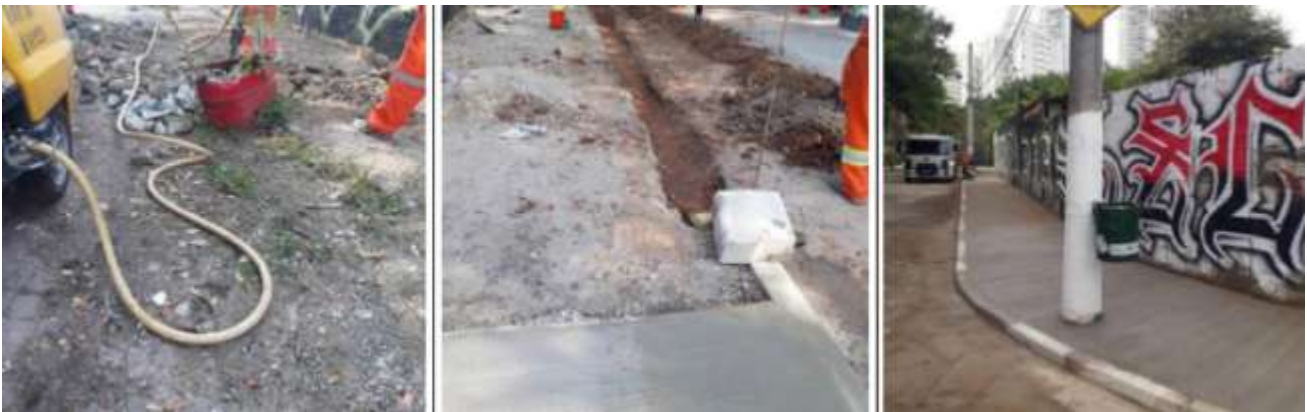
Reforma de calçada
