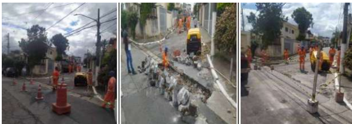
Reforma de sarjetão
