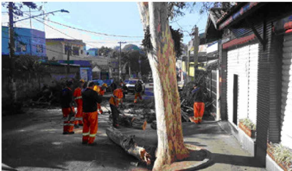
Remoção de galhos de árvore com queda na Rua Juvêncio de Araújo Figueiredo
