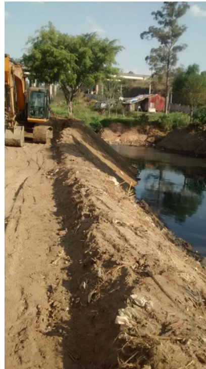
Escavadeira hidráulica trabalhando no desassoreamento
