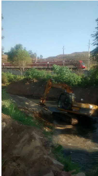
Escavadeira hidráulica trabalhando no desassoreamento
