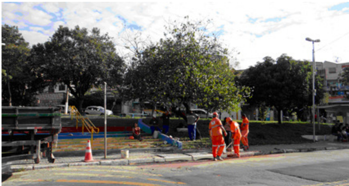
Conserto e manutenção de boca de lobo na Rua Leopoldo de Passos Lima
