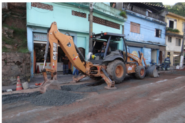
Obras da SABESP para contenção de refluxo de esgoto na Av. Fiorelli Peccicacco.
