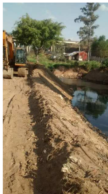
Escavadeira hidráulica trabalhando no desassoreamento
