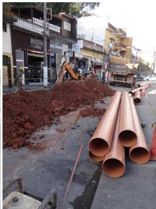
Obras da SABESP para contenção de refluxo de esgoto na Av. Fiorelli Peccicacco.
