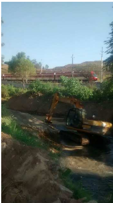
Escavadeira hidráulica trabalhando no desassoreamento
