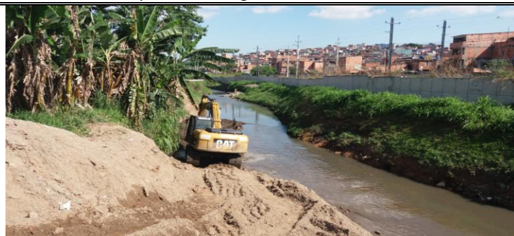
Limpeza de córrego – Ribeirão Perus - Domingos Antônio di Sandro
