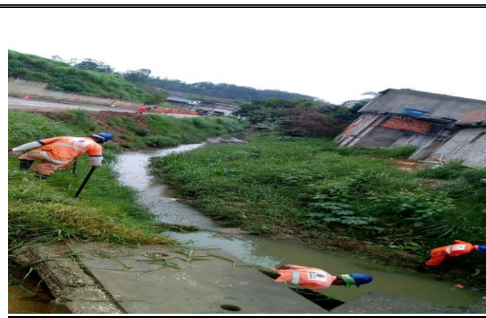
Limpeza manual de córregos – R. Cleonice Kammer Di Sandro
