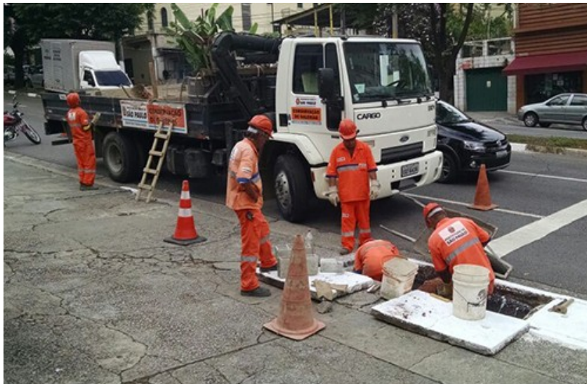
Legenda: Exemplo de Serviço de Drenagem
