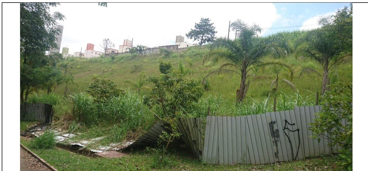
Foto 02 – Foto da Rua José Balangio (Talude) em verificação in loco em 13/12/2017
