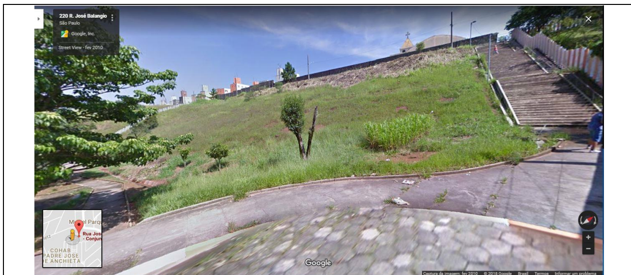
Foto 01 – Vista da Rua José Balangio (Talude) pelo Google Maps (Fev/2010)
