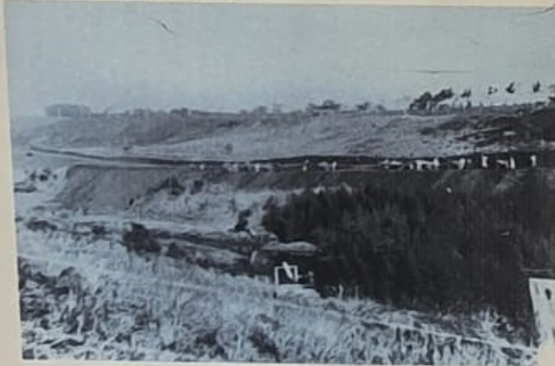
Início das obras da Cia City no loteamento do Alto da Lapa. Década de 1920. Acervo Cia City.
