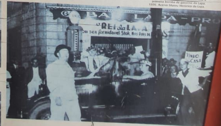
Bar Lapa Progrido, onde foi instalada a primeira bomba de gasolina da Lapa. 1936. Acervo Museu Histórico da Lapa.
