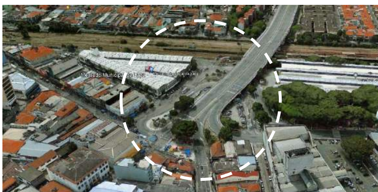
Praça Melvin Jones, recortada pelo Viaduto da Lapa. Fonte: Google Earth, 2023.
