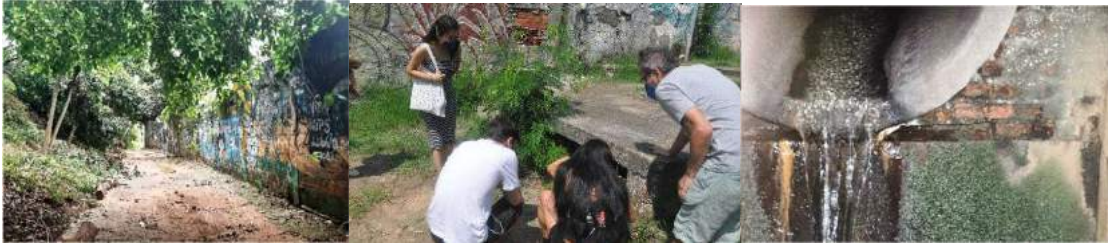
Vuela sanitária que conecta praça São Crispim à Olavo de Peres Velasco. Foto: Renata Priore Lima, 19/08/2021.
