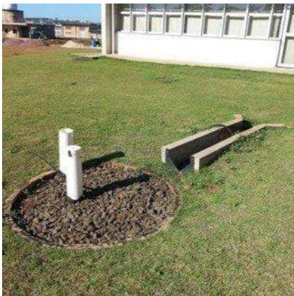
Vala de infiltração com trincheira de direcionamento (UFSCar) e vala com canaleta e tampa. Fonte: Gutierrez & Ramos (2019).
