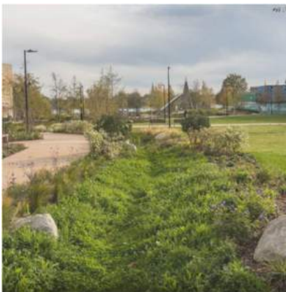
Vala de infiltração inserida em área verde e posicionada junto a passeio para captação de água da chuva. Fonte: Gutierrez & Ramos (2019).
