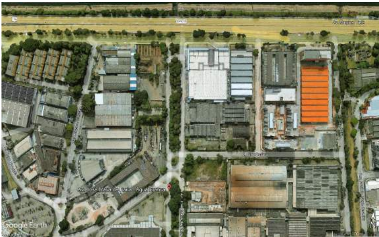
Foto satélite da foz do córrego Tiburtino que passa canalizado sob avenida José Maria de Faria. Fonte: Google Earth, 2023.
