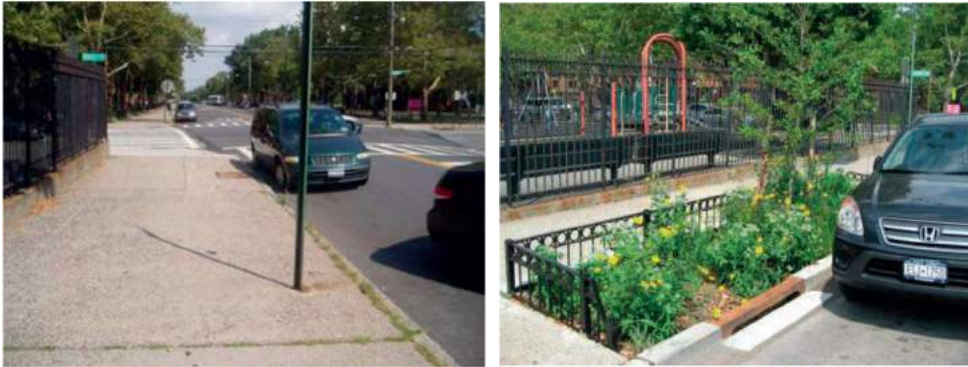
Referência de biovaleta implantada em Nova York. Fonte: NYC Green Infrastructure Plan (2022, p. 61).
