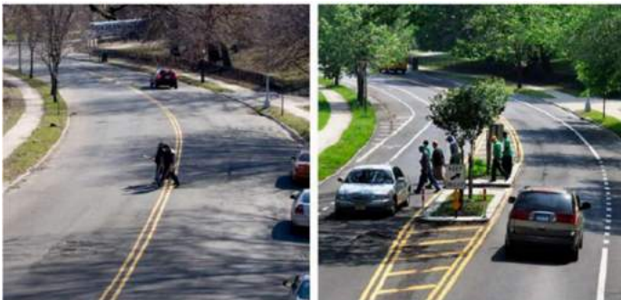
Transformação do desenho viário com inclusão de canteiros centrais parciais e arborização. Fonte: NYC Green Infrastructure Plan (2022).
