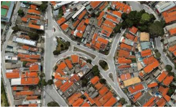
Cruzamento da rua Sepetiba com rua Mipibu. Fonte: Google Earth.
