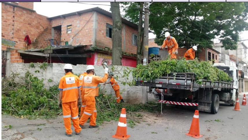
Poda de árvore – Rua Tingoassuiba
