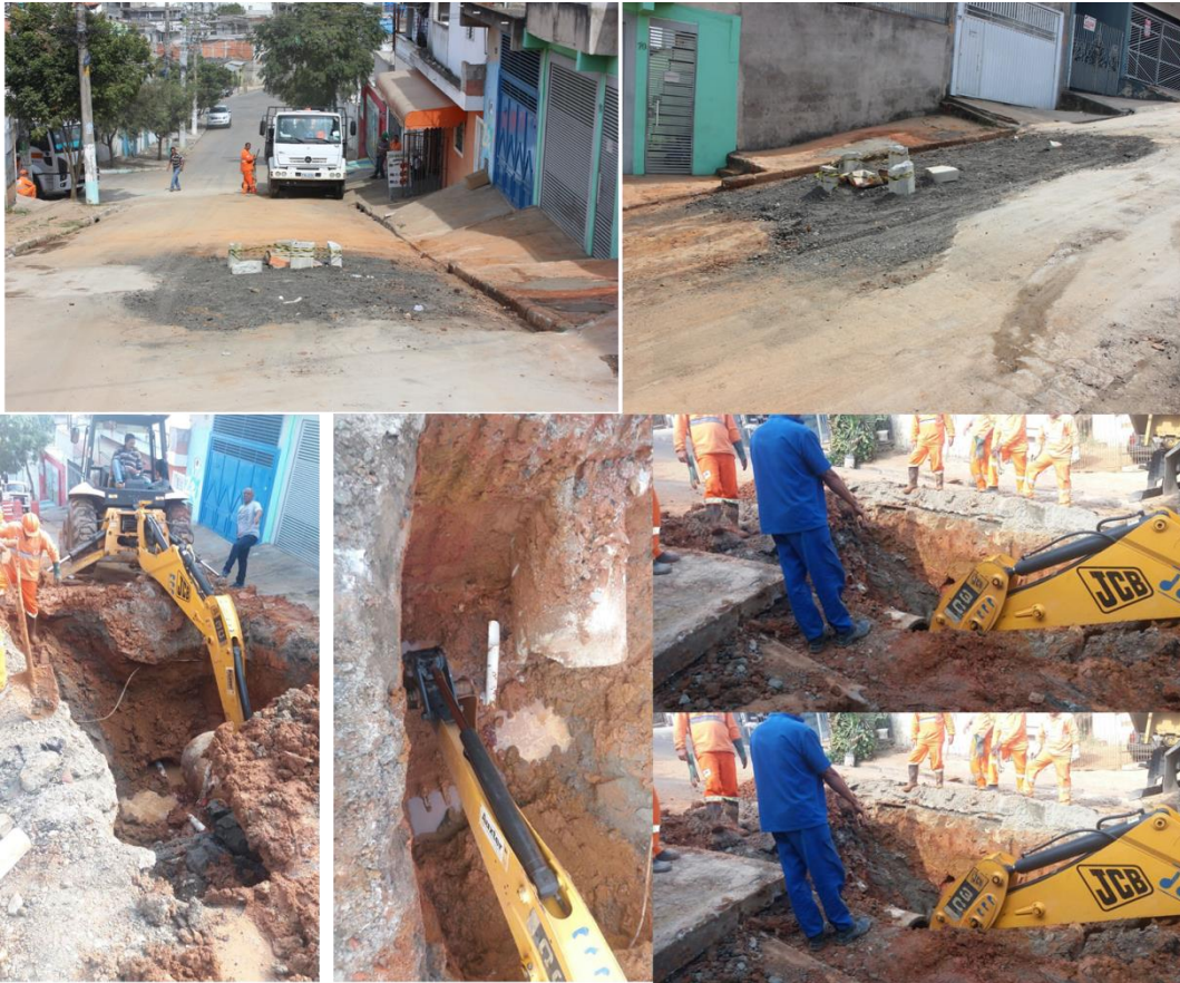
Reforma de Galeria – Rua Serra da Queimada
