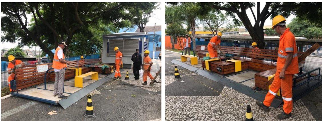
Reforma do Parklet e agora está na Rua Hipólito de Camargo
