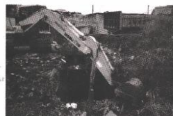
Máquinas trabalhando na limpeza de córrego
