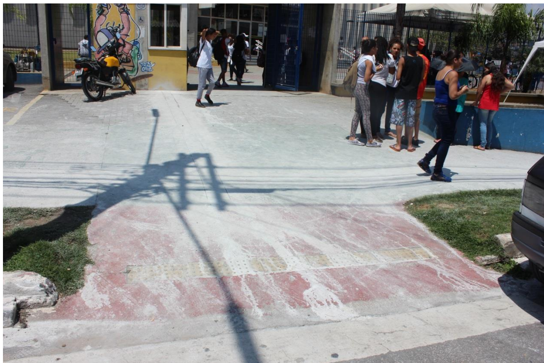
Acessibilidade entrada do CEU Lajeado
