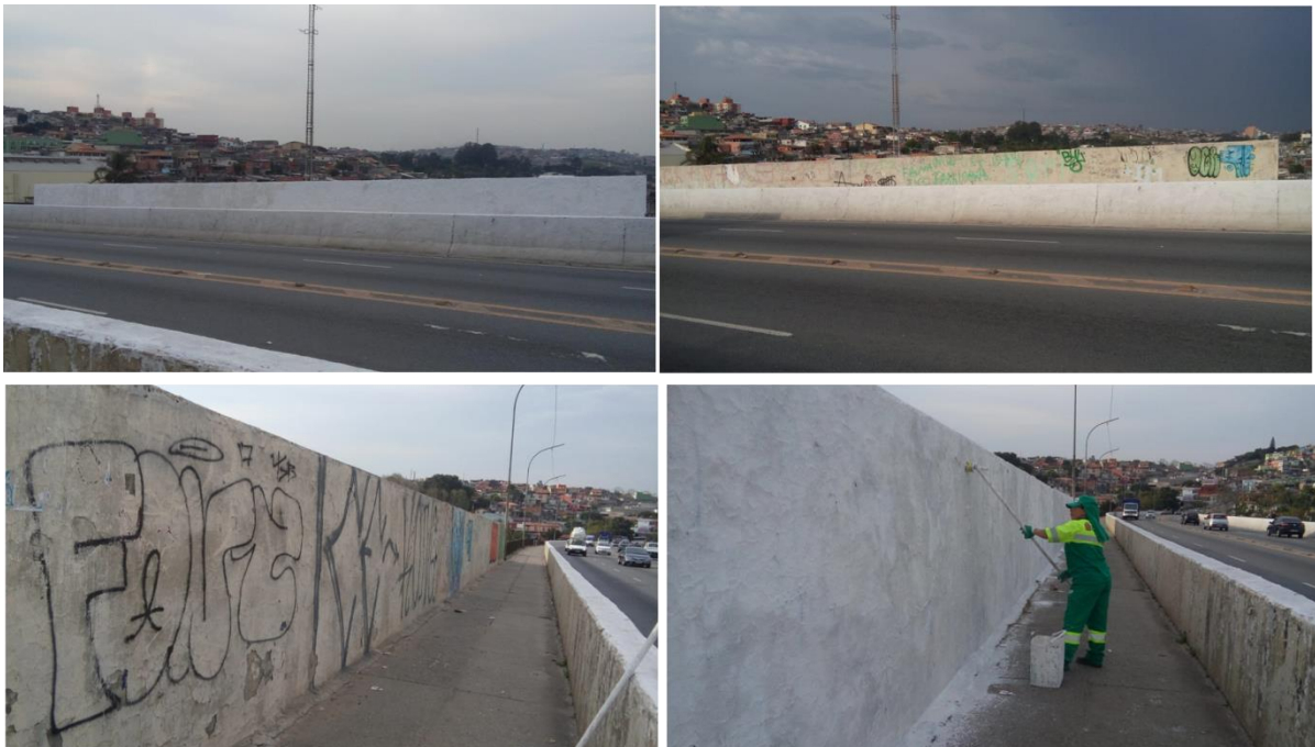
Pintura de viaduto - Rua Saturnino Pereira
