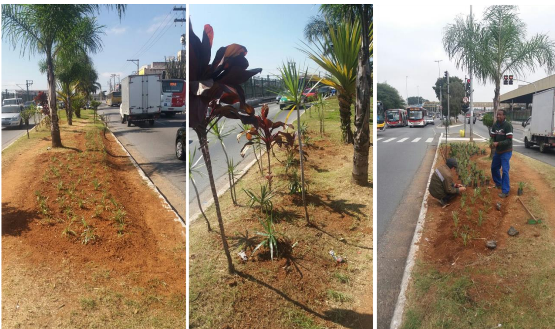
Canteiro – Rua Salvador Gianetti
