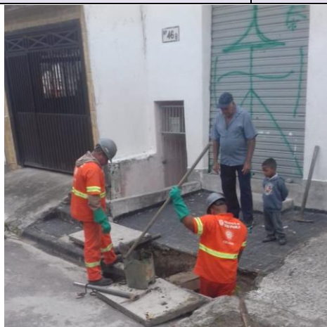
Limpeza de bueiros – Rua Aldeia Maria
