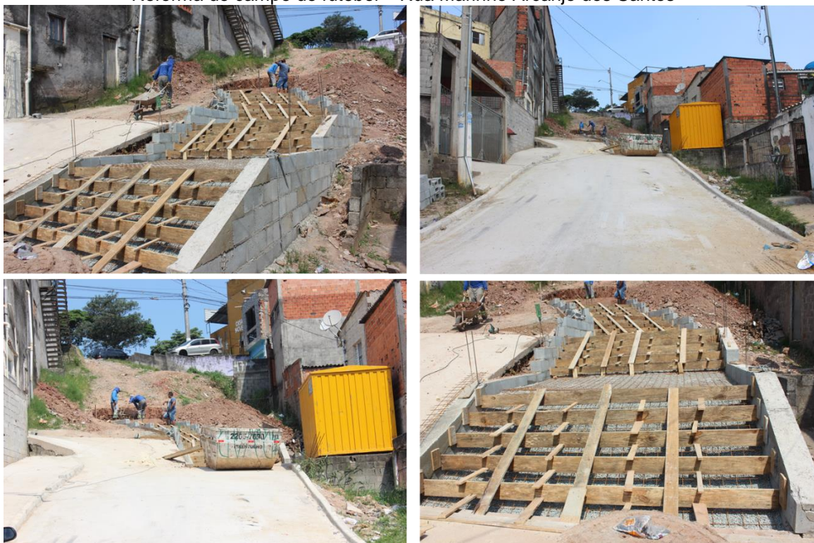
Escadaria – Rua Engenheiro Ernani Cotrim
