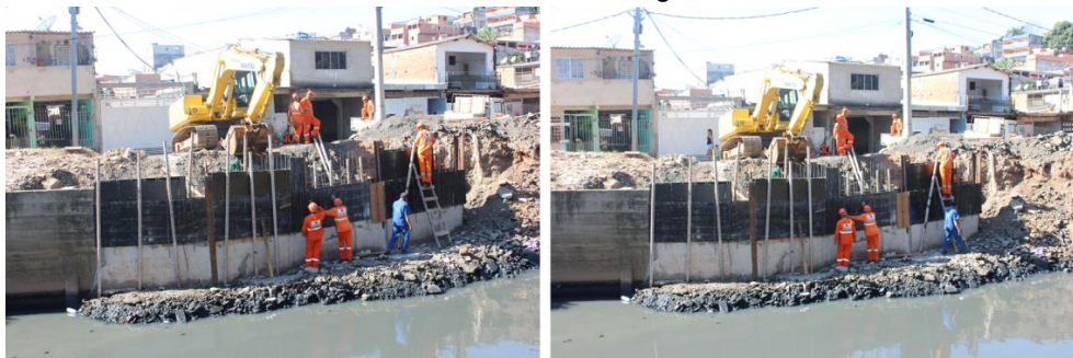
Obra de contenção em parceria com a fábrica Manikraft
