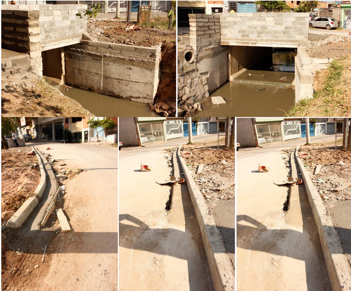
Contenção -Rua Vereda Alfa
