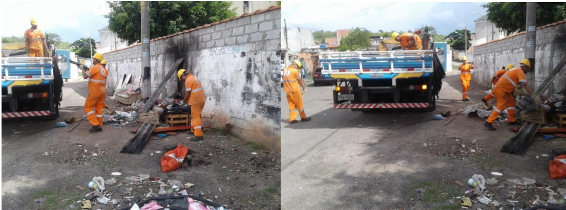
Limpeza de ponto viciado de entulho – Rua Santa Etelvina
