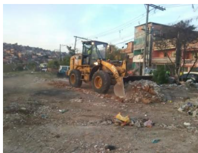
Limpeza mecanizada na Rua Juan Alfama
