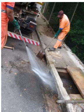
Limpeza de bueiros na Rua Francesco Mancini
