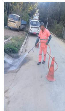
Hidrojato na Rua da Saúde (1)
