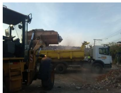
Limpeza mecanizada na Rua Juan Alfama
