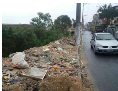
Limpeza mecanizada na Rua Guacuri
