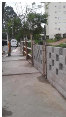
Mureta na Av. Nossa Senhora do Sabará
