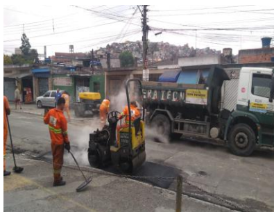
Operação Tapa-Buraco na Rua Wilson Cantoni
