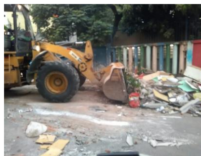
Limpeza na Rua Djalma Correia
