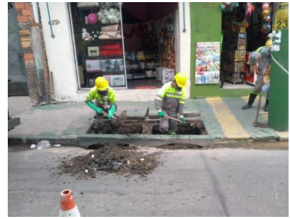
Limpeza de bueiro na Rua Samuel Arnold
