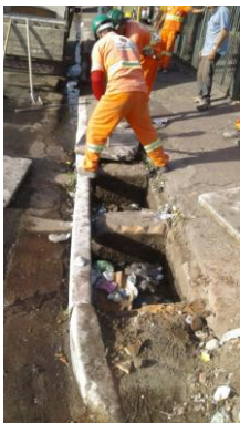
Trocas de tampas e nivelamentos na Av. Cupecê
