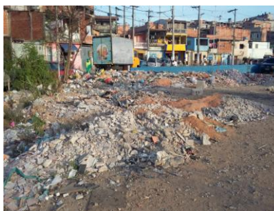
Limpeza mecanizada na Rua Juan Alfama
