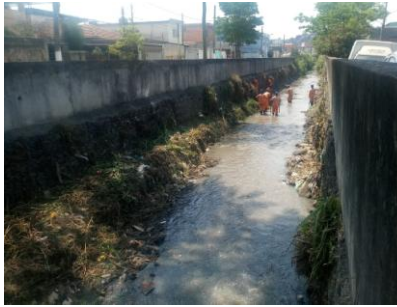
Limpeza de córrego na Rua Arquiteto Felipe Joaquim Júnior
