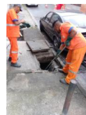
Limpeza de bueiro na Travessa Poeta Aprendiz
