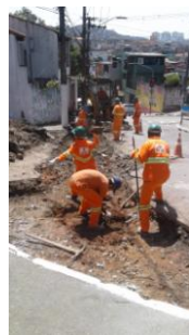
Reforma de sarjeta na Av. Bento XV
