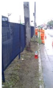
Conservação de áreas ajardinadas no corredor central da Av. Cupecê
