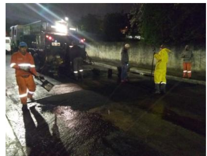
Operação Tapa-Buraco na Rua Córrego Azul
