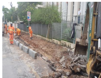
Reforma de calçada na Rua Córrego Azul
