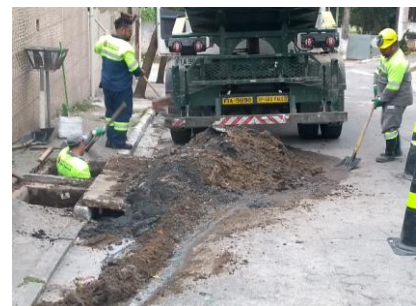
Limpeza de bueiro na Rua Gonçalo Camacho
