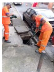
Limpeza de bueiro na Travessa Poeta Aprendiz
