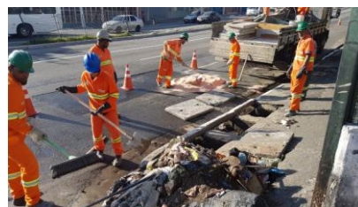
Ação nos grandes corredores – Avenidas Cupecê e Vereador João de Luca
