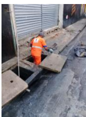
Limpeza de bueiro na Travessa Poeta Aprendiz
