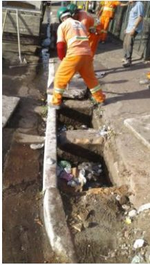
Limpeza na Rua Denis Furtel
