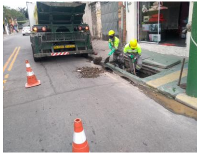
Limpeza de bueiro na Rua Samuel Arnold
