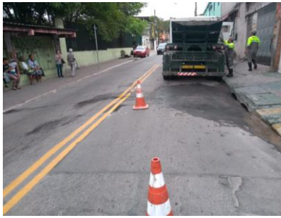
Limpeza de bueiro na Rua Samuel Arnold
