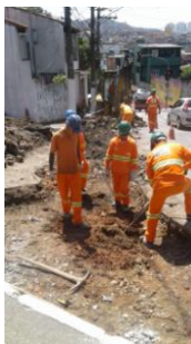
Reforma de sarjeta na Av. Bento XV
