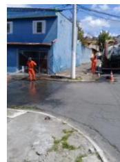
Limpeza de bueiro na Rua Luigi Bassi
