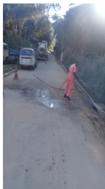
Hidrojato na Rua da Saúde
