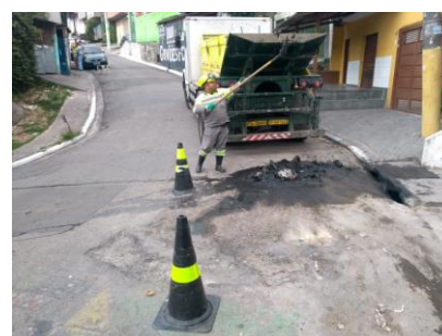
Limpeza de bueiros na Rua Americanópolis
