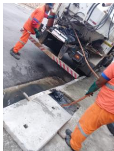
Hidrojato na Rua dos Marimbás
