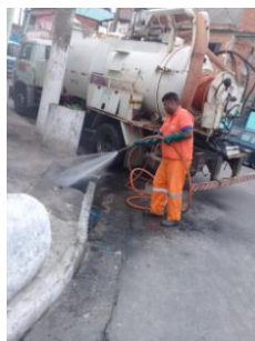
Hidrojato na Rua dos Marimbás
