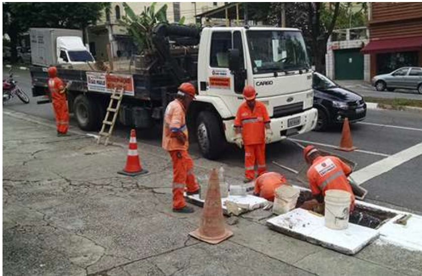
Legenda: Exemplo de Serviço de Drenagem
