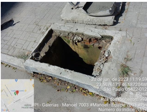
Reforma em poço de visitas, antes e depois:
