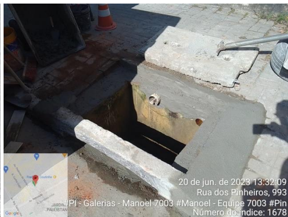
Reparo na estrutura da caixa de coleta, antes e depois:
