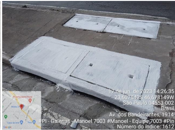
Reparo na estrutura da caixa de coleta, antes e depois:
