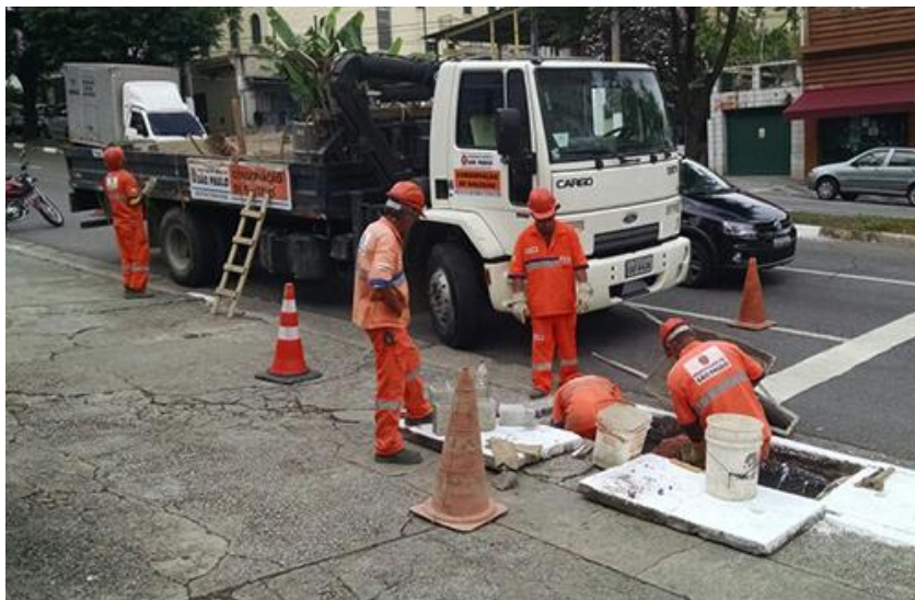
Legenda: Exemplo de Serviço de Drenagem
