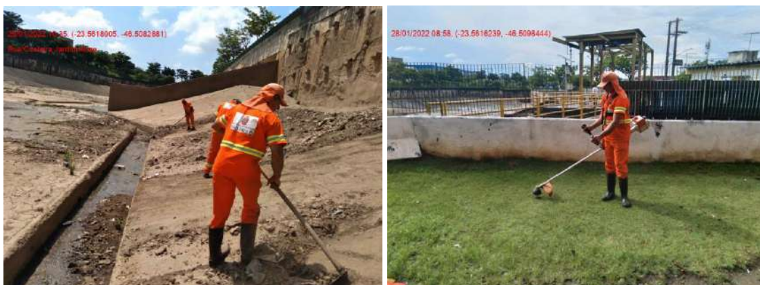
Registro feito por equipe de manutenção e limpeza do piscinão: 1 – Limpeza interna, 2 - Limpeza externa
