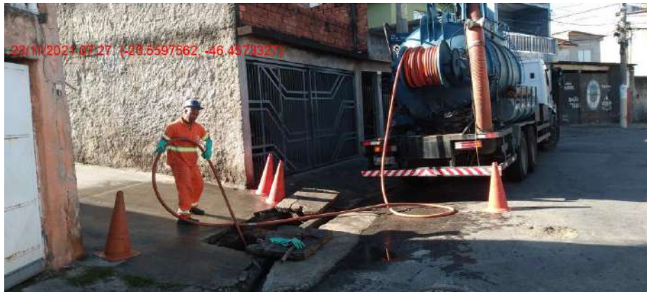
Registro feito por equipe de Limpeza com Hidrojato: Limpeza mecanizada de boca de lobo – Rua Rio das Contas
