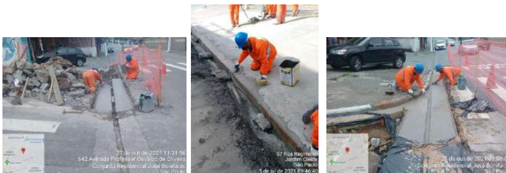
Registros feitos por equipes de manutenção de logradouros
