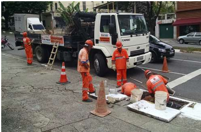
Legenda: Exemplo de Serviço de Drenagem
