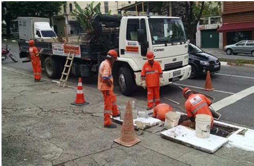
Legenda: Exemplo de Serviço de Drenagem
