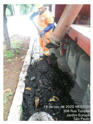
Retirada dos detritos do tanque após a sucção
