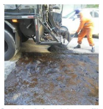
Foto 4 – Após a aplicação, aguardando a massa asfáltica
