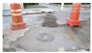
Os anexos acima mostram a construção da boca de lobo, assentamento da guiachapéu, extensão da sarjeta, construção de ramal e construção do poço de visitas.
