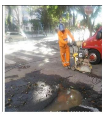
Foto 1- Requadramento do buraco, primeiramente utilizando a serra diamantada e posteriormente, o martelete
