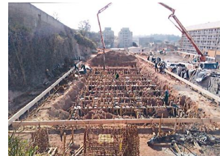
Concretagem e vigas
