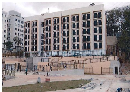
Rampa de Acessibilidade
