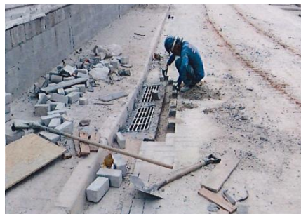
Execução de drenagem
