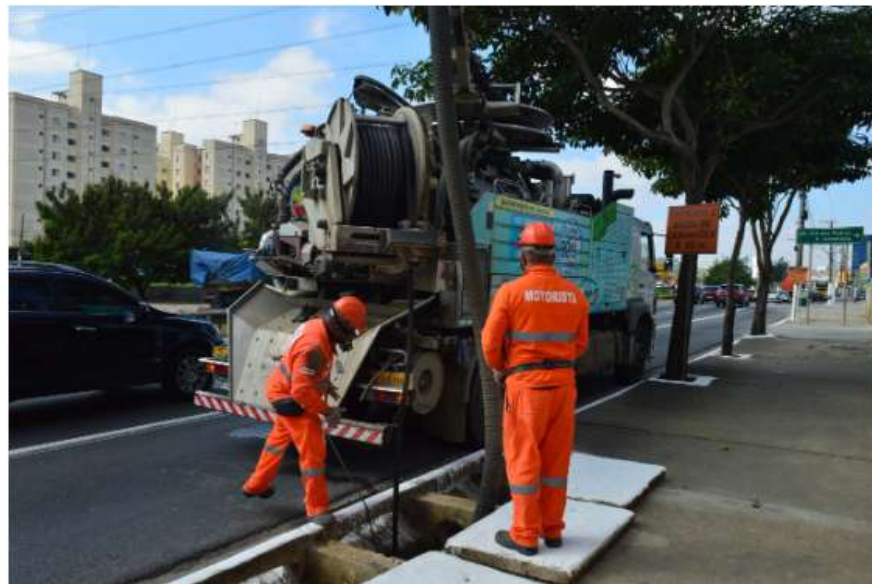
Legenda: Exemplo de Serviço de Microdrenagem.
