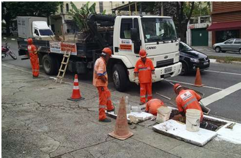
Legenda: Exemplo de Serviço de Drenagem
