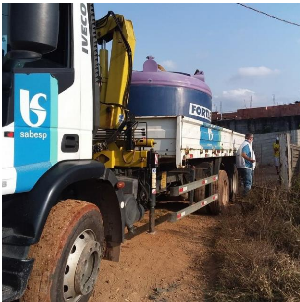
Instalação de rede pelo Água Legal e doação de caixas d'água
