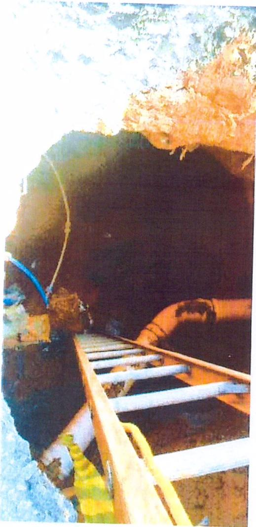
Foto nº 05 Caixa de Águas pluviais rompida
