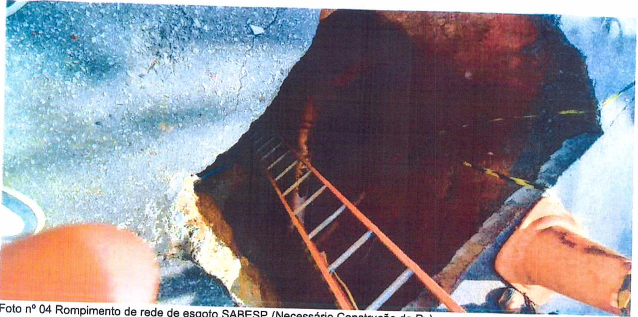
Foto nº 04 Rompimento de rede de esgoto SABESP (Necessário Construção de Pv)
