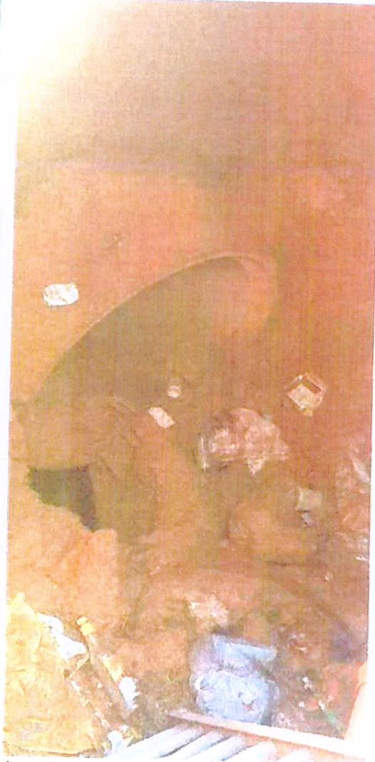
Foto nº 06 Rede de águas pluviais rompida
