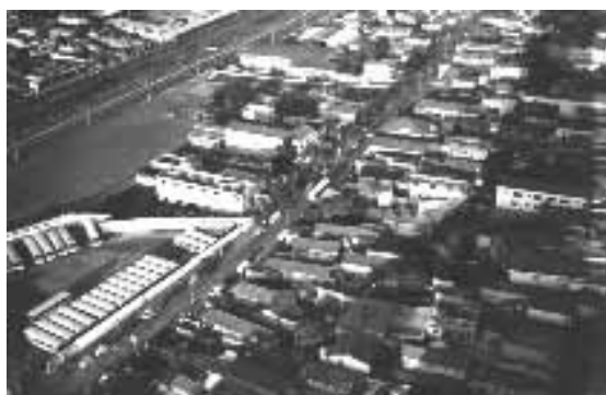
Após a canalização (1999)
