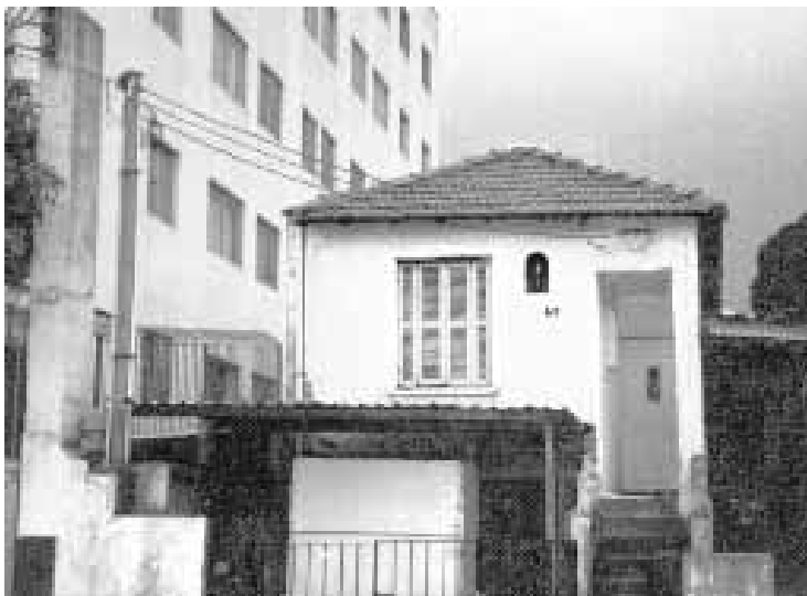
Casa ao lado de prédio, construída em 1951, com pequena varanda e um nicho com a imagem de São Sebastião (estilo utilizado pelos primeiros moradores, desde 1922). Rua do Trabalho, n.º 78 (1997)
