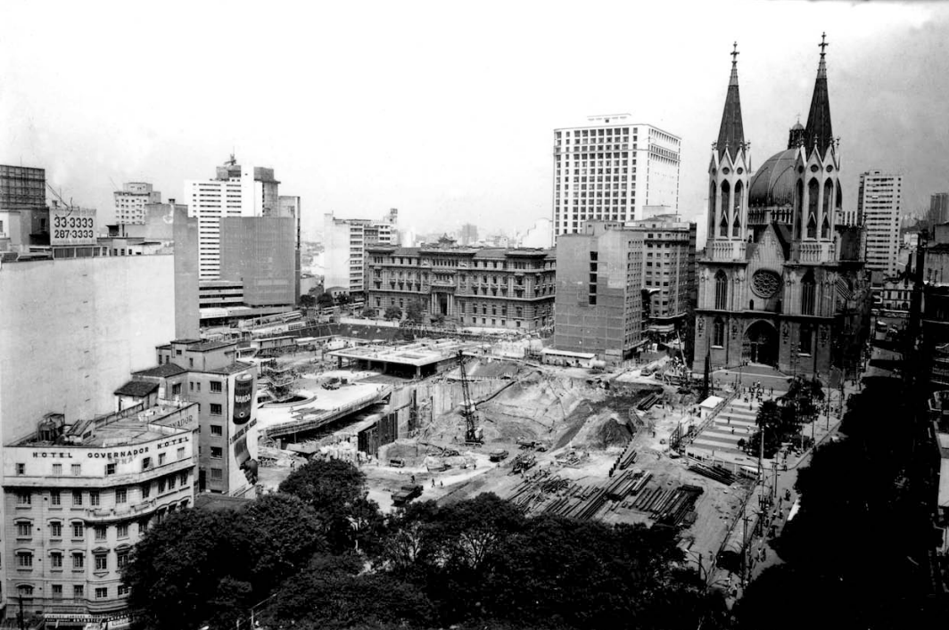
Praça da Sé, construção do Metrô, déc. 1970. [H]
