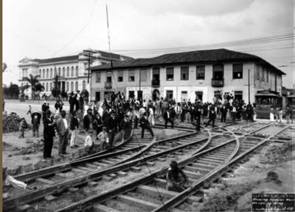
Instalação de trilhos de bondes elétricos, Av. Celso Garcia, 1900. [14, E]
