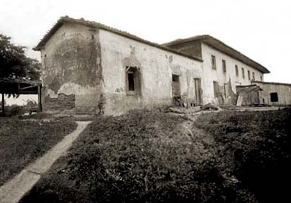
Fazenda Santana, demolição, c. 1915. [17, k]
