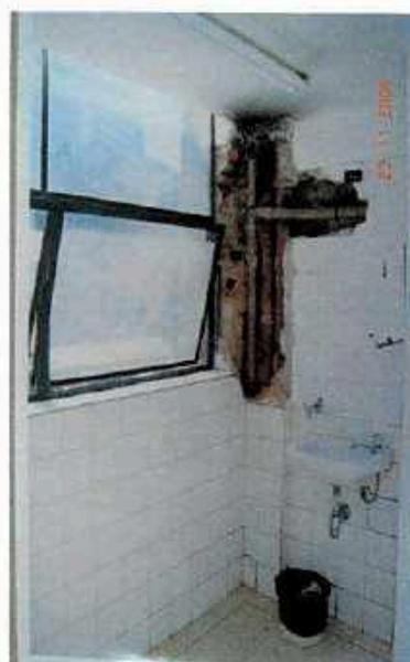
*Amostra da antiga tubulação de PVC deteriorada antes da reforma hidráulica. Os constantes vazamentos impossibilitavam a reparação da alvenaria e a biblioteca apresentava rombos como este por todo o edifício.*
