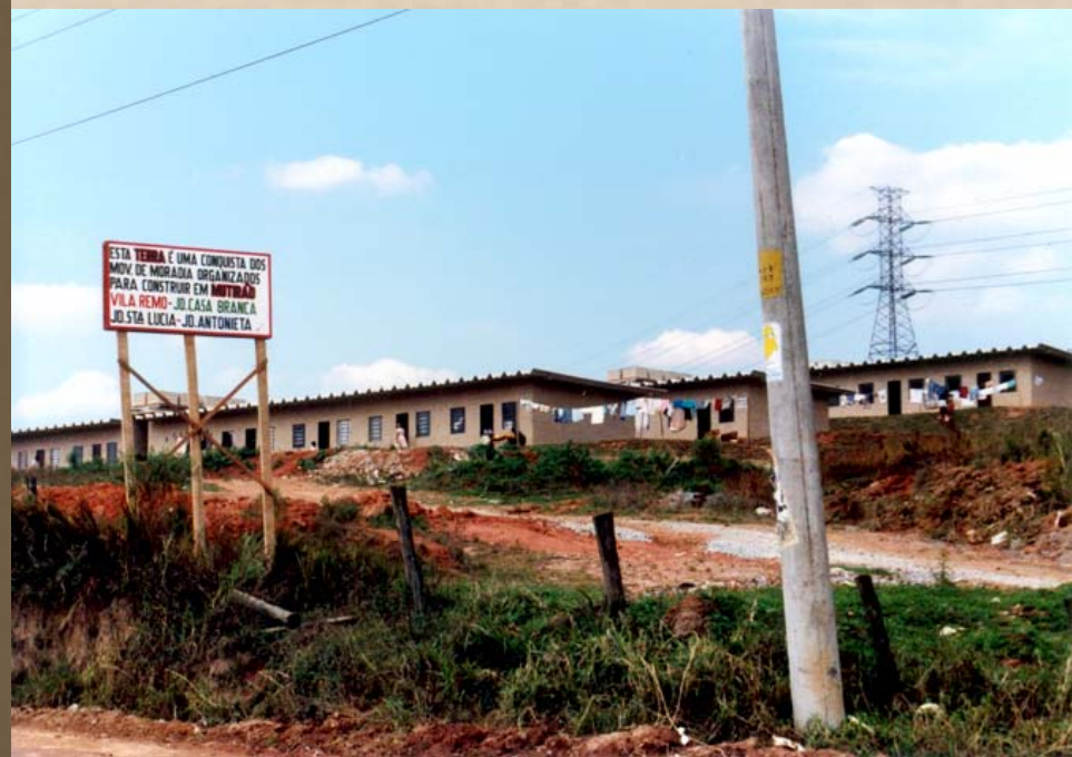
Jardim Rosana , moradias construídas em mutirão, déc. 1990. [B]
