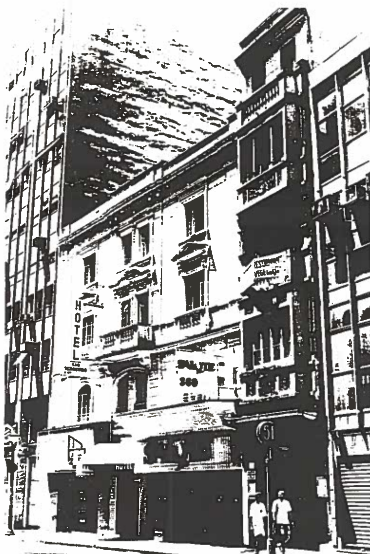
Dois prédios de características ecléticas, isolados na Rua Sete de Abril.
