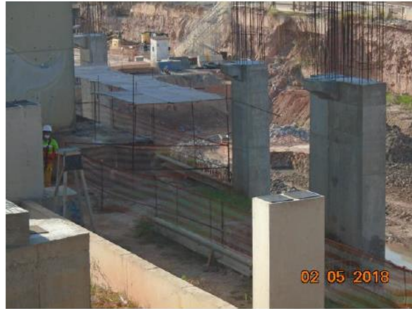
Foto n°. 02 – Aparelho de apoio sobre pilares para receber vigas.
