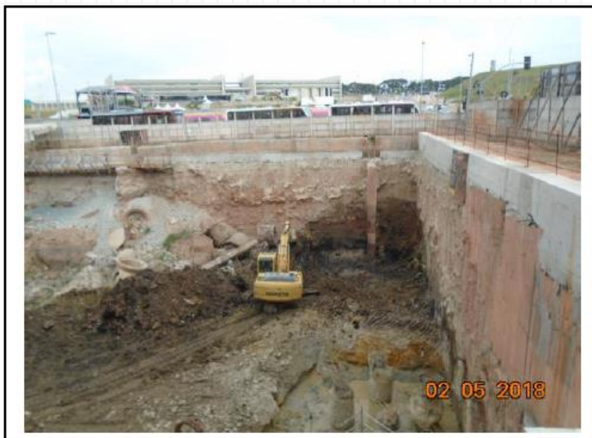
Foto n.º. 03 – Escavação e remoção de terra para o bota fora.
