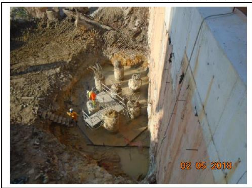
Foto n°. 01 – Arrasamento das estacas para construção do bloco.
