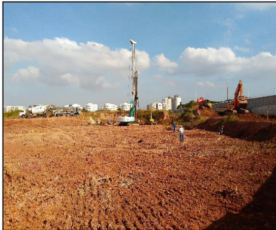
CONDOMÍNIO 3A – OBRAS A SEREM INICIADAS
