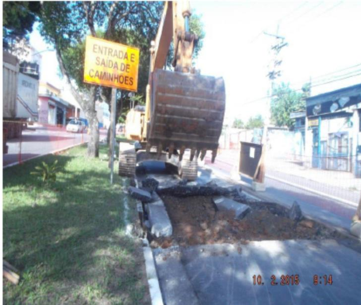
**Demolição de pavimento flexível (asfalto) para abertura da caixa de construção da faixa do Corredor de Ônibus.**
