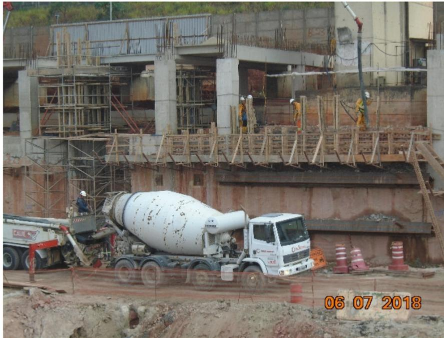
Lançamento de concreto para construção da viga de coroamento
