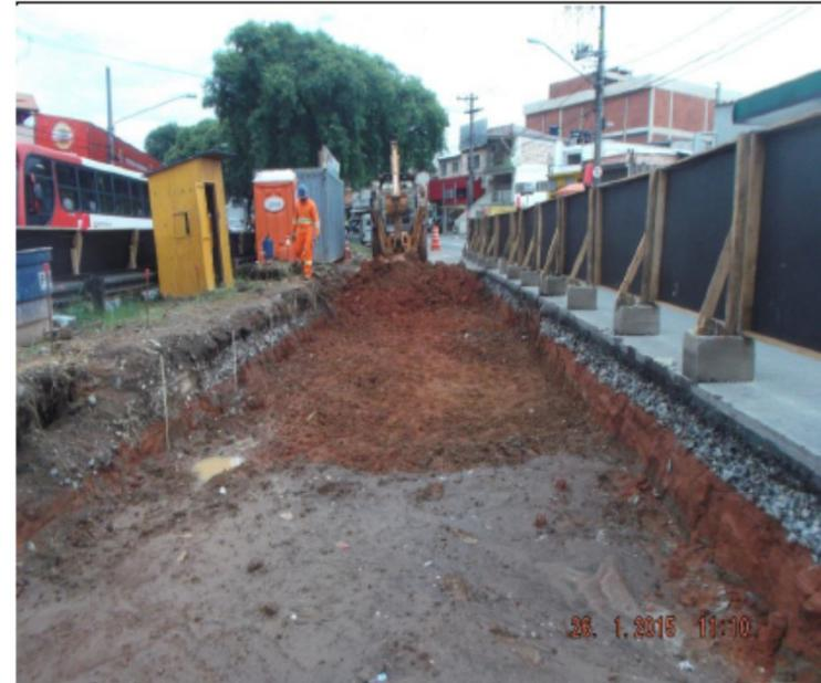
**Abertura da caixa e escavação para construção da faixa do Corredor de Ônibus.**
