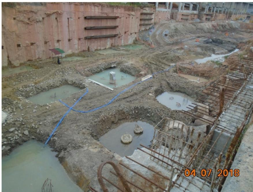
Vista do bombeamento de água na área de escavação do terminal
