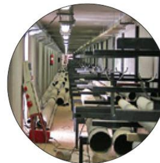
ENTERRAMENTO DE REDES
