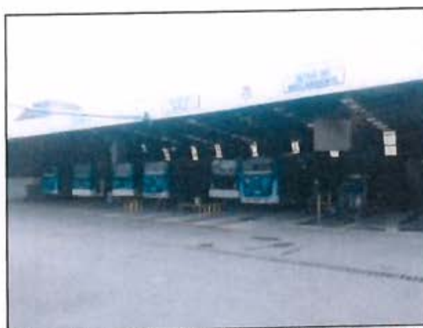
Figura 5 – Detalhe da pavimentação da garagem
