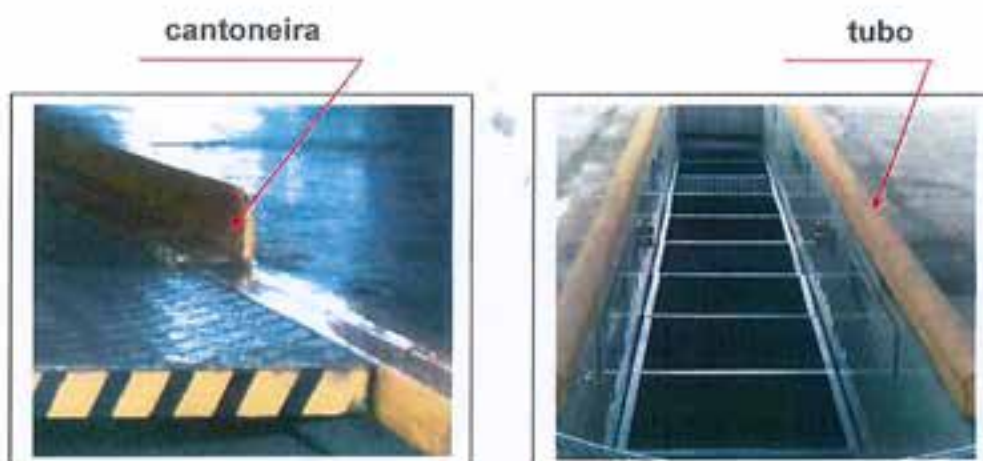
Figura 4 – Guias de proteção de valetas
