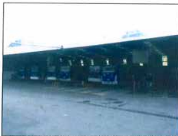
Figura 5 – Detalhe da pavimentação da garagem
