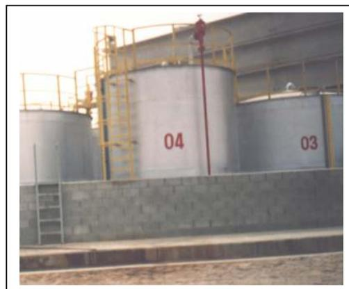
Deve existir uma válvula de alívio por tanque, como forma de liberar os gases do seu interior, bem como respiros e aterramento para evitar os efeitos de eletricidade estática.
