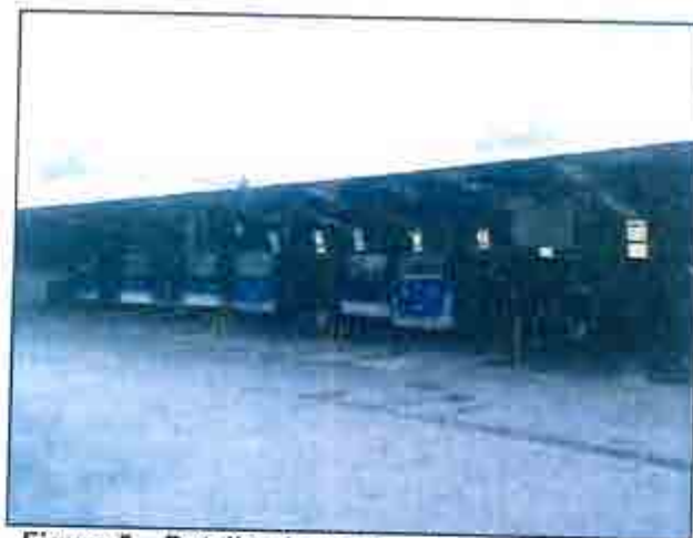
Figura 5 – Detalhe da pavimentação da garagem
