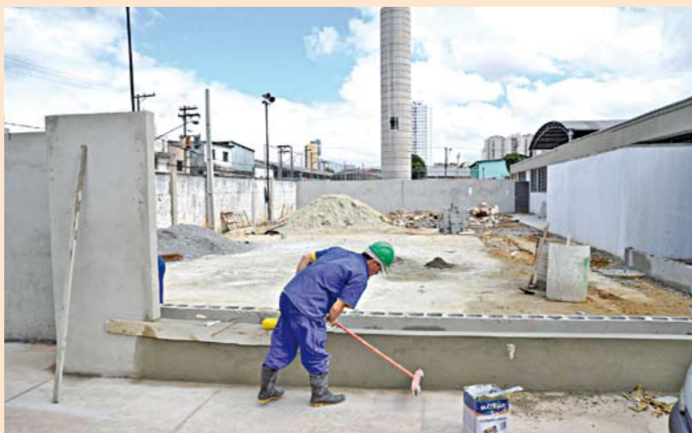
Construção pré-moldada: cada unidade fica pronta em oito meses
