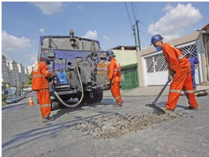
Funcionários trabalham na Operação Tapa-Buraco
