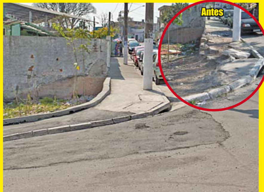
Passado da rua Feliciano de Mendonça: sem buracos e desníveis
