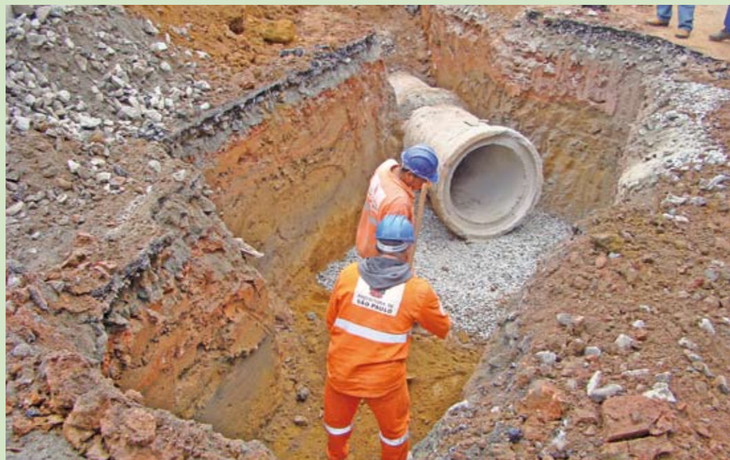
Obra na rua João Baruel: 300 metros de galerias
