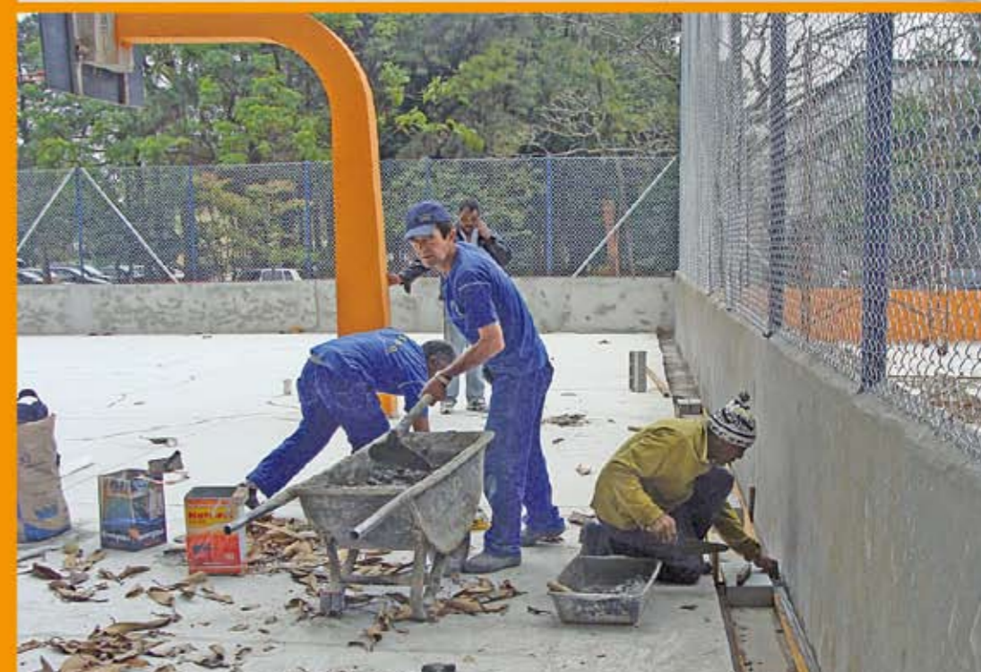
Operários trabalham no clube escola
