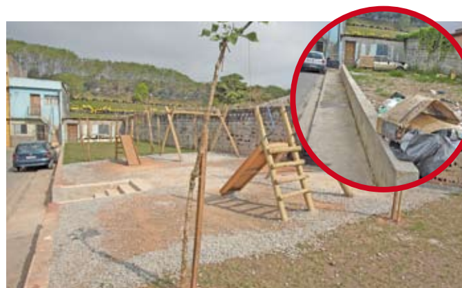
Rua Francisco de Torres depois das intervenções e antes (no detalhe)
